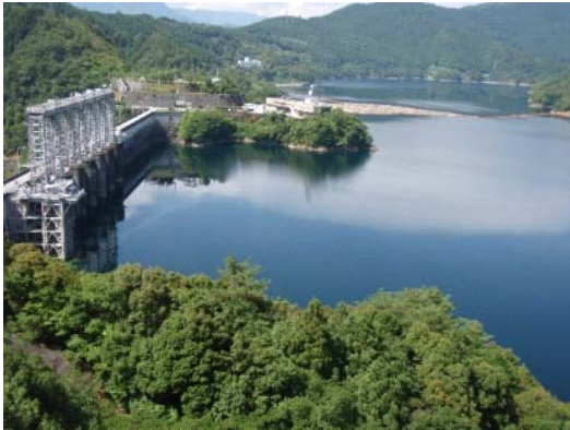
早明浦ダム満水の状況
