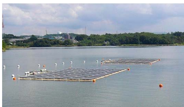
水面に設置した太陽光発電実験設備
