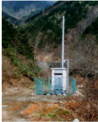
写真-1 雨量観測設備
