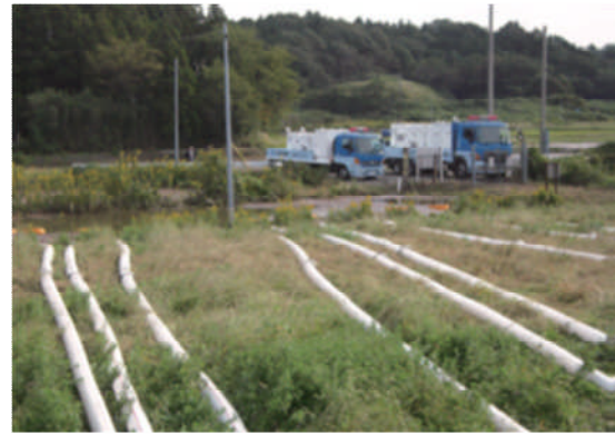
写真-7 ポンプ車排水状況
