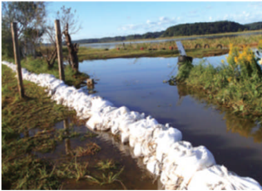
写真-6 土のう積み応急対応状況
