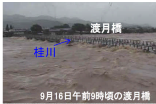
写真-4 渡月橋の状況写真
