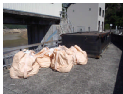
写真-4 台船、土のう等準備状況
