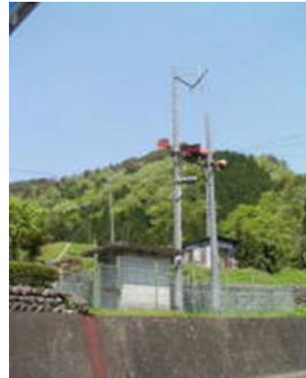
写真-2 警報設備
