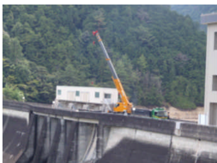
写真-3 資材搬入状況
