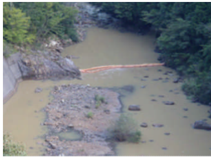
写真-5 濁水防止フェンス設置状況
