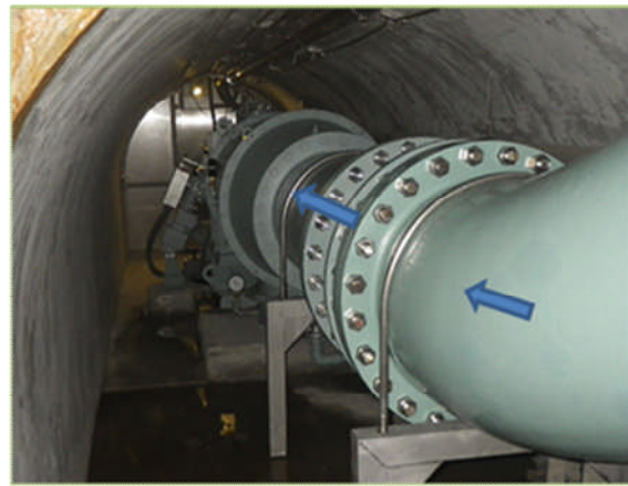
写真-2 初瀬水路取水塔小水力発電設備 (形式: フロントフランシス水車)
