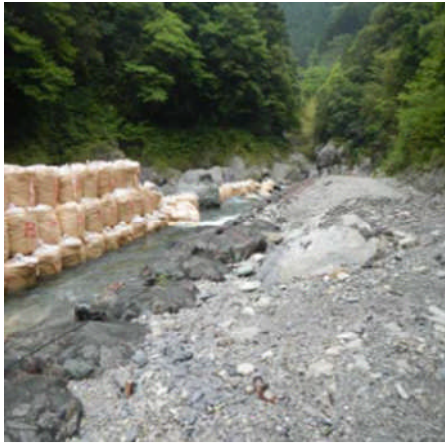
流路護岸状況（平成25年5月）
