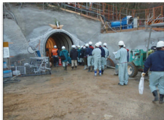
写真-4 トンネル新設工事の現地研修
