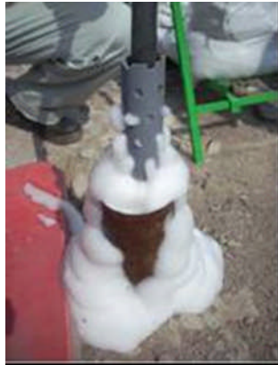
写真-1 泡による導通
