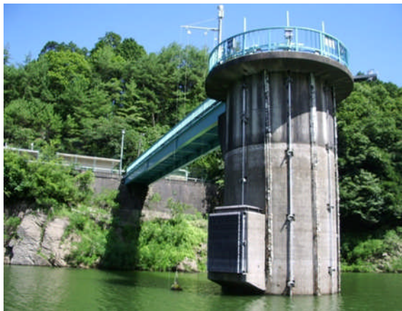
写真-1 初瀬水路取水塔全景
