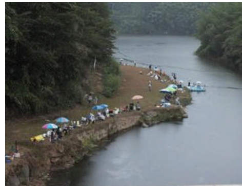
写真-7 ダム湖を活用したつり大会 (布目ダム)
