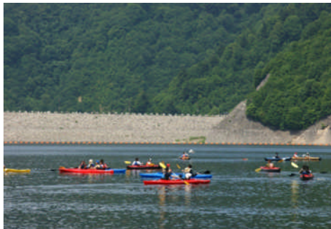
写真-4 湖面利用 (カヌー) (奈良俣ダム)
