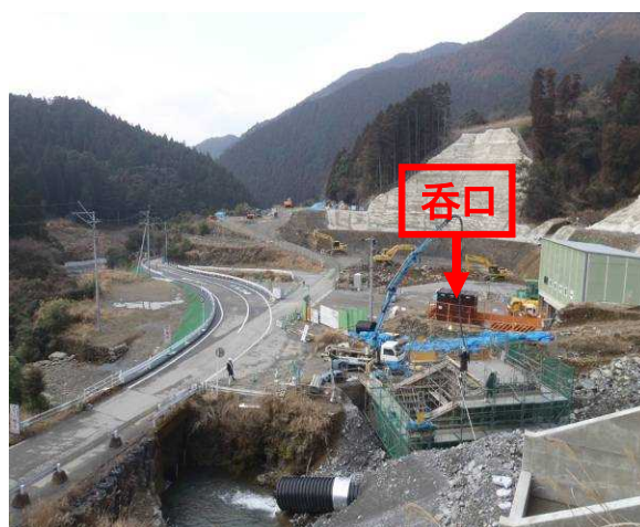
写真-4 転流工工事実施状況
