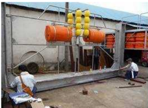
写真-3 通船ゲート設備の工場検査
