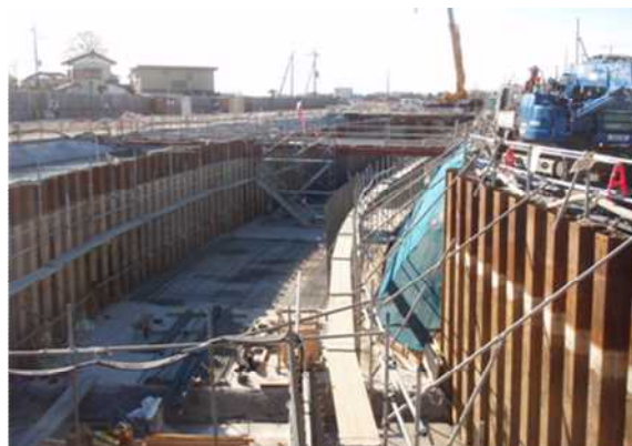
写真-2 水路改築工事実施状況
