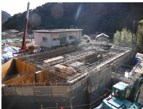
写真-5 神測沈砂池工事実施状況
