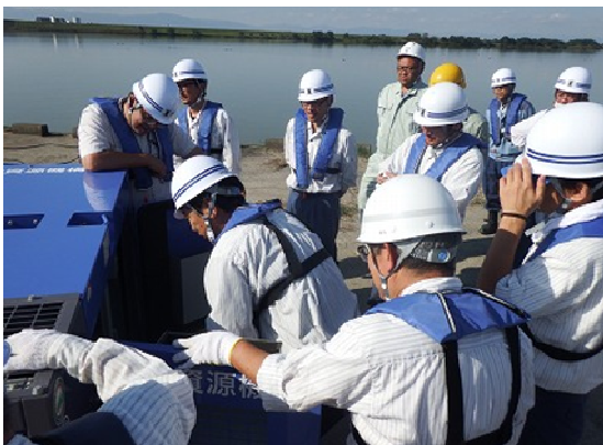
③可搬式発電機始動前確認
