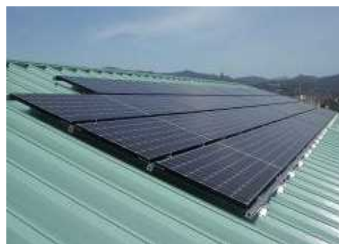
写真－3 両筑平野用水太陽光発電設備
