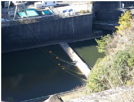
①減勢工内ポンプ設置状況
