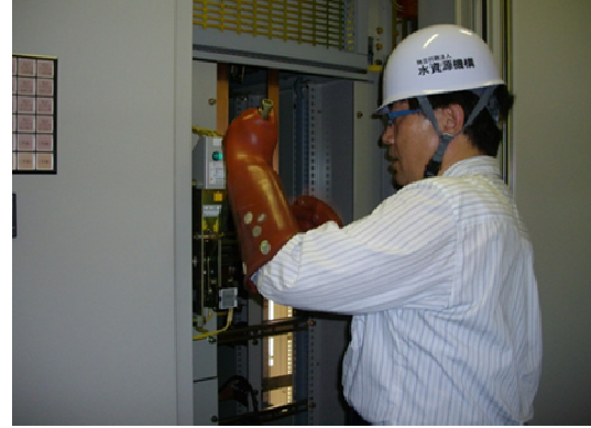
②真空遮断機の手動操作
