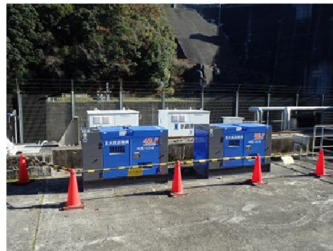
②発電機・操作盤設置状況
