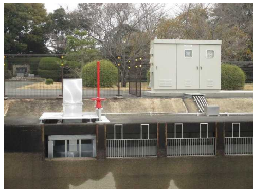
写真－1 豊川用水二川水位調節堰小水力発電設備
