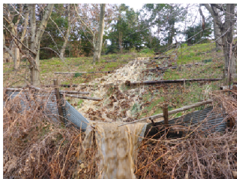
①漏水発生時の状況
