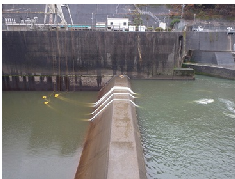
③減勢工内排水作業状況
