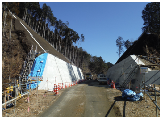
写真-1 付替県道工事（栗沢7工区）実施状況
