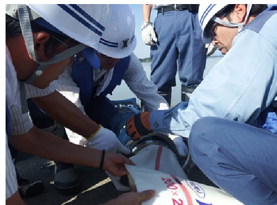
④ホース接続作業
