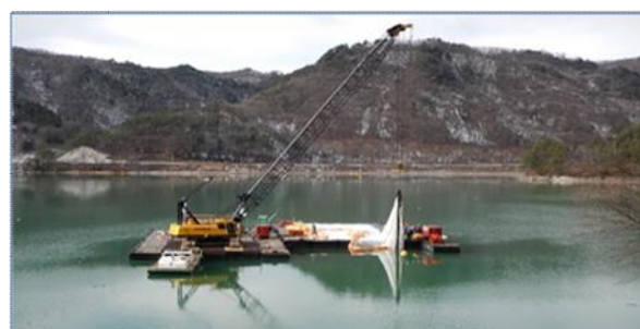
写真-3 水質汚濁防止膜設置状況（12月10日）
