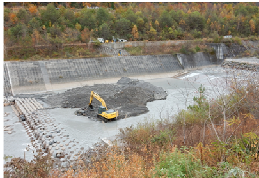
写真-2 2号貯砂ダム土砂撤去状況（10月31日）
