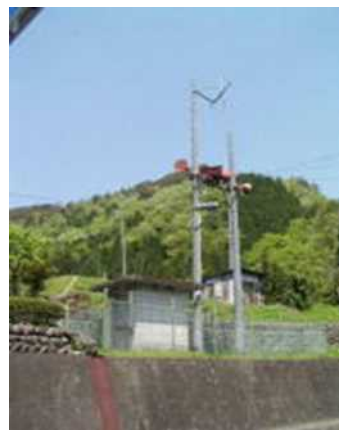
写真-2 警報設備
