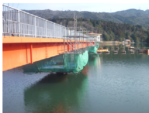
写真－2 三重用水施設（打上調整池）の落橋防止工事実施状況
