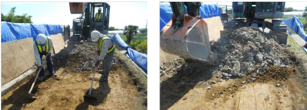
写真-5 防護シートによる飛散防止対策を施しての撤去作業状況
