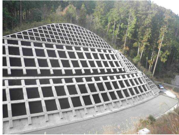
写真-3 付替県道工事（青山美杉線2-5工区）実施状況
