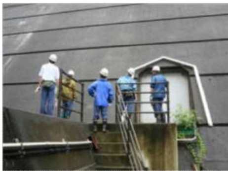
①地震時の堤体臨時点検訓練
