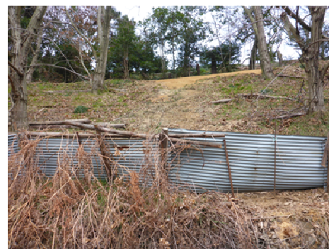
②復旧完了
