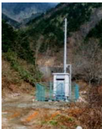
写真-1 雨量観測設備
