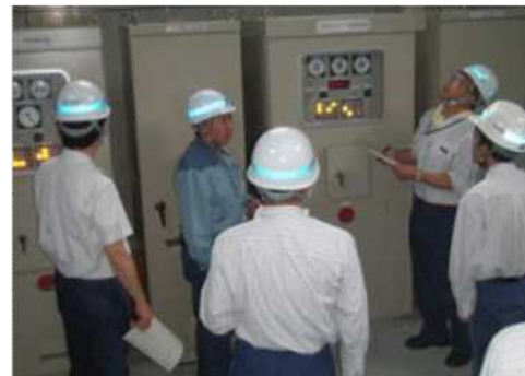
②施設点検確認訓練
