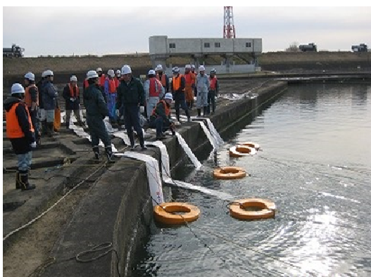
⑤ホース接続作業
