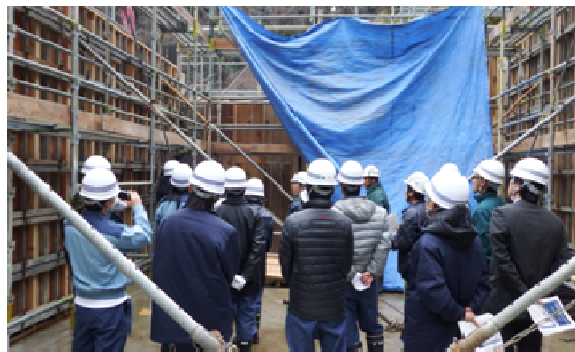
写真-3 現地研修（沈砂池築造）
