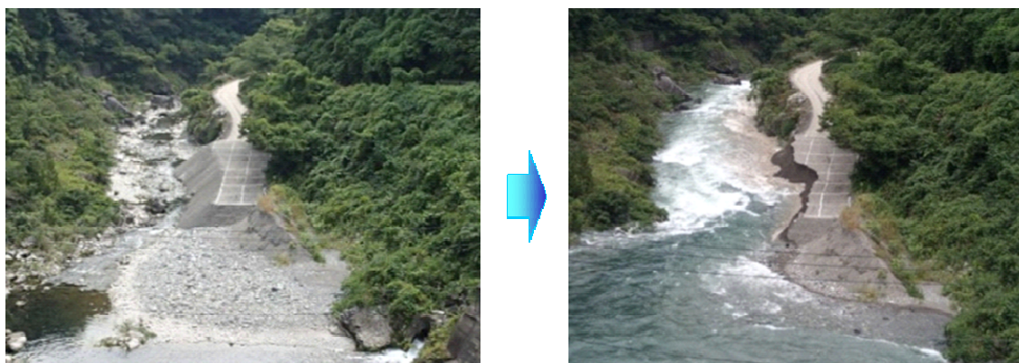
①土砂の置土状況
