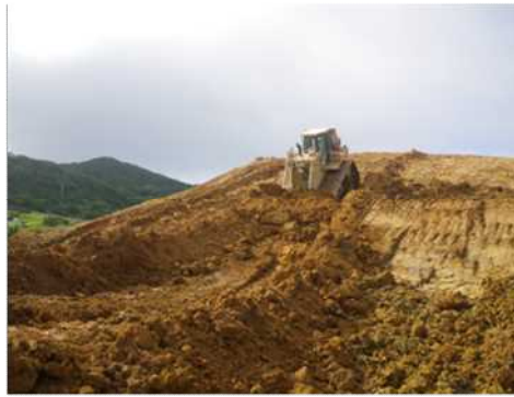
写真-1 ストックパイルの混合掘削・搬出状況
