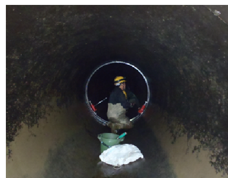
④継手補強材設置
