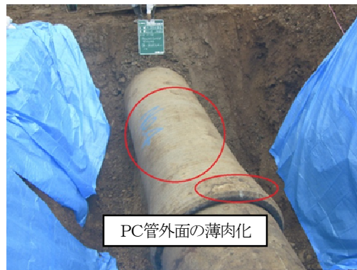
写真－2 木曾川用水施設の老朽化状況
