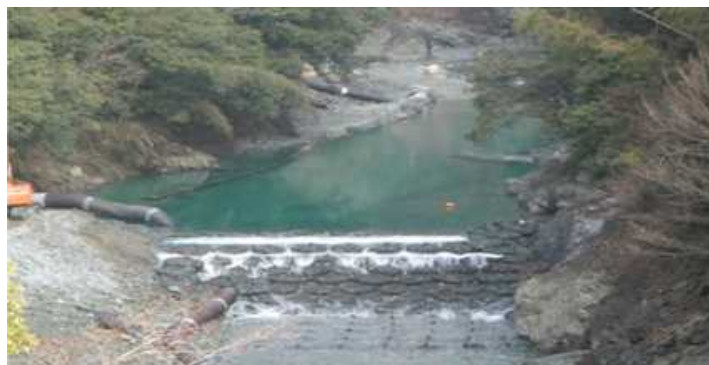
写真-6 流入支川における堰堤設置状況（早明浦ダム）
