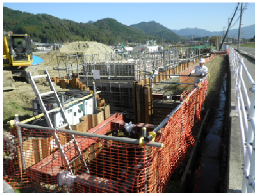
写真-7 草場川分水工改築工事実施状況
