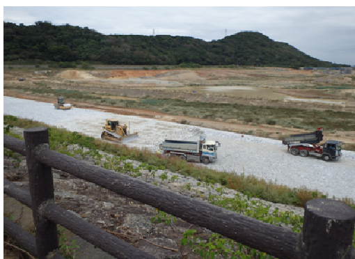
写真-6 初立池補強工事実施状況
