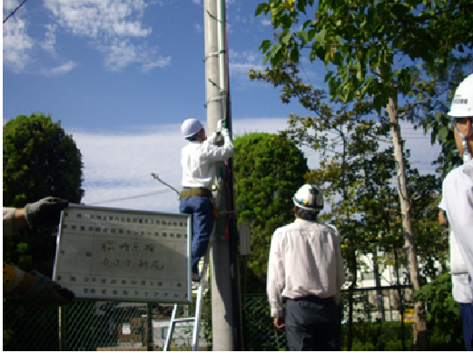
①柱上開閉器の手動操作
