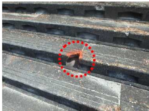
塗料塗布による危険明示（応急措置）
