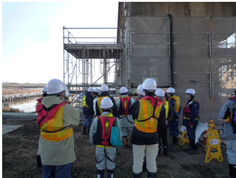
写真－3 現地研修（堰柱の耐震補強）
