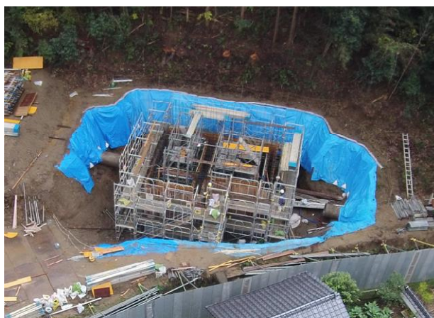
写真-12 山浦分水工改築工事実施状況
