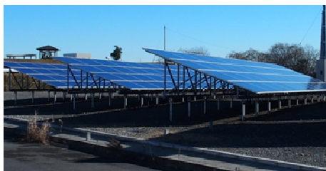
写真-3 印旛沼開発太陽光発電設備
