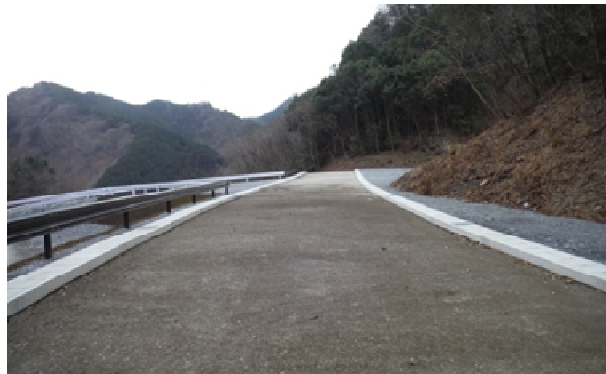
写真－1 付替県道上久我栃木線（栗沢工区）実施状況
