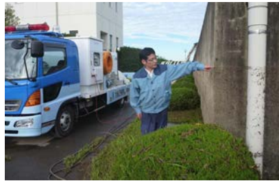
④排水作業後の状況（指の位置まで冠水）
