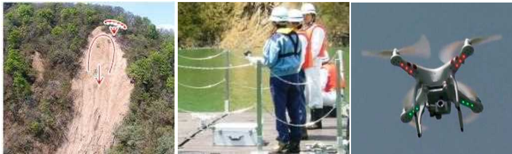
写真-1 マルチコプターによる貯水池斜面の調査状況
