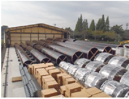
①備蓄資材（鋼管、継手補強材等） （開閉式倉庫）
