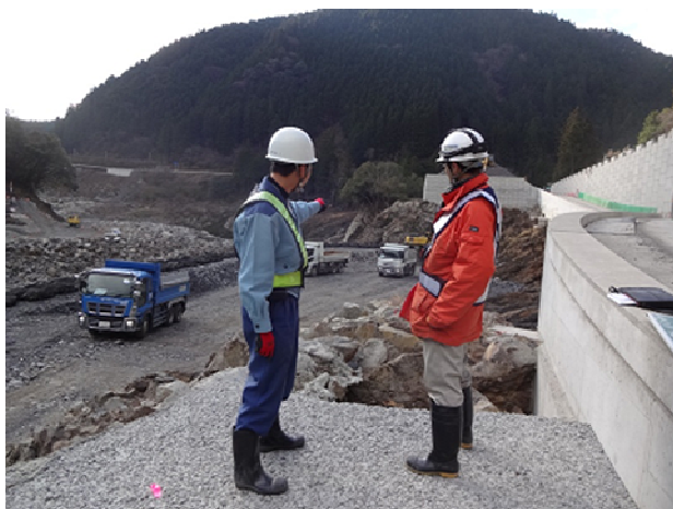
写真-1 平成27年度那賀川ダム本体等工事監督支援業務現場打合わせ風景
