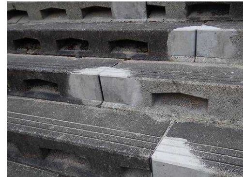
破損部の補修完了
