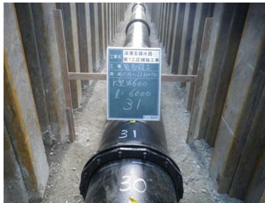
写真－1 機能保全対策（三重用水）
