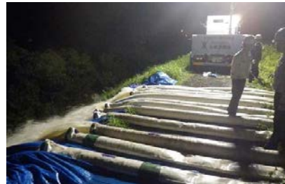
②夜を徹しての排水状況
