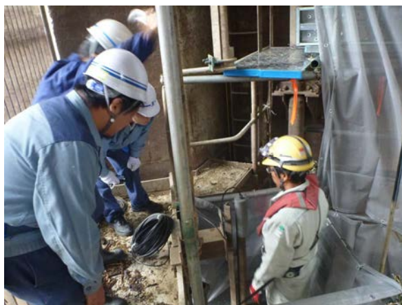
写真－5 ゲート整備工事の現地研修
