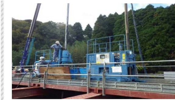
写真-1 スーパージェット工法施工状況
