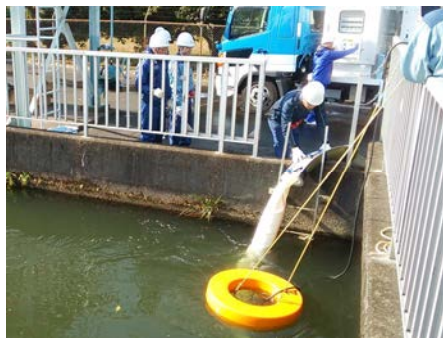
③ポンプ設置
