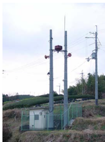
写真-2 警報設備
