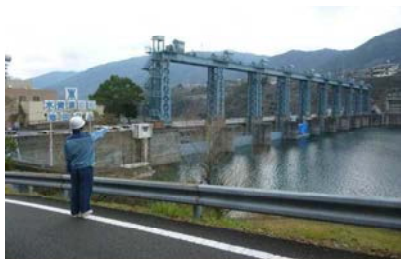
写真-1 貯水池巡視状況 (池田ダム総合管理所)
