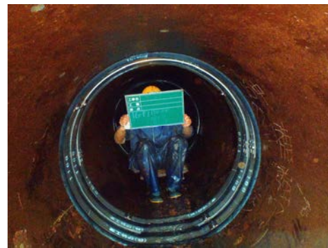
②復旧完了
