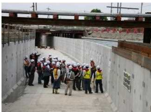
写真-1 5月24日 水路内見学状況
