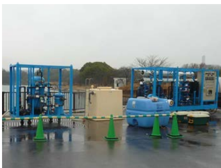
①可搬式浄水装置の設置
