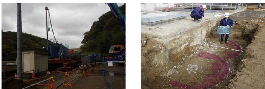
写真-10 長柄バルブ室耐震補強工事実施状況（地盤改良）
