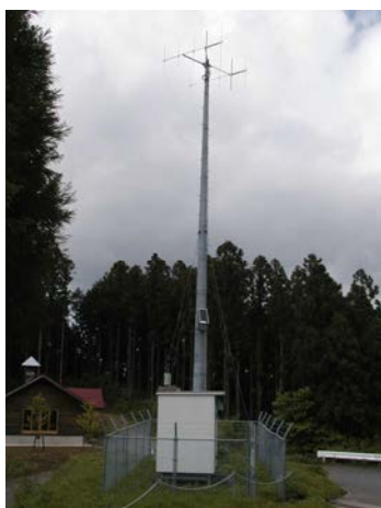
写真-1 雨量観測設備
