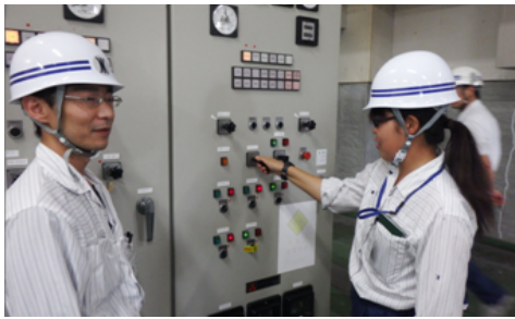
①非常用電源設備操作訓練
