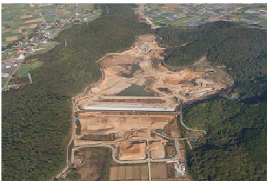
写真－1 豊川用水施設（初立池） の補強工事実施状況
