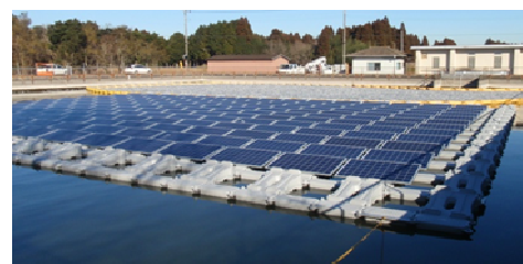
写真-4 北総東部用水太陽光発電設備
