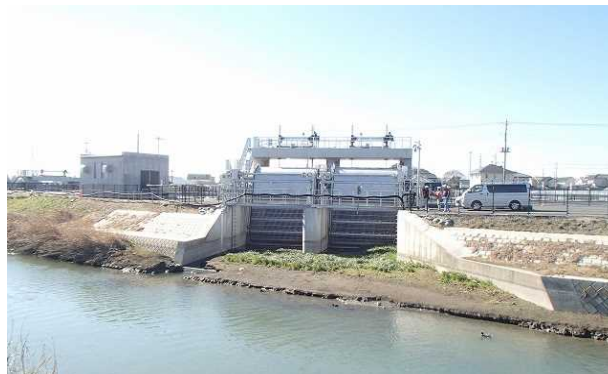
写真－2 改築が完了した川面水門
