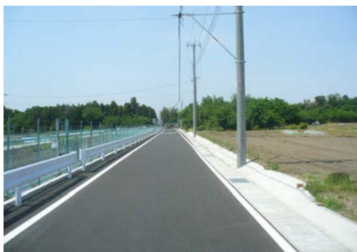
写真-1 平成27年度に移管が完了した管理用道路（群馬用水）
