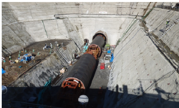
写真-7 仮排水路トンネル工事実施状況
