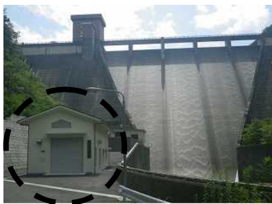
写真-1 豊川用水大島ダム小水力発電設備
