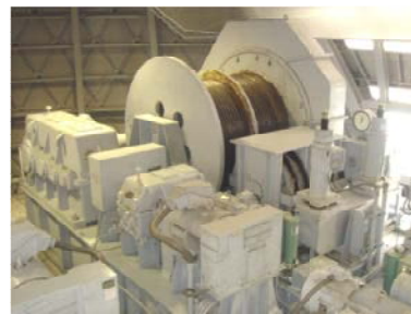
写真-2 ゲート開閉装置
