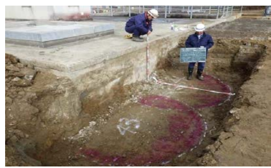
写真-2 改良体の出来型確認状況
