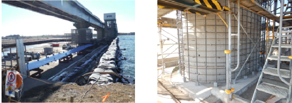
写真-8 利根大堰の耐震補強工事実施状況
