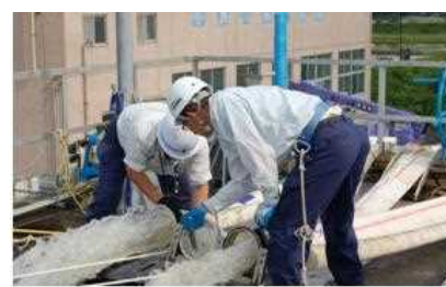
②排水状況
