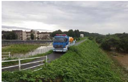
①浸水状況の確認及び準備状況
