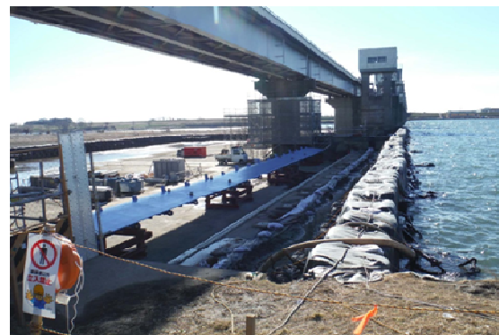
写真－2 利根大堰等施設 の補強工事実施状況
