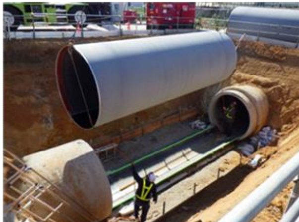
写真-11 芦ヶ池サイホン補強工事（第1回変更計画）実施状況
