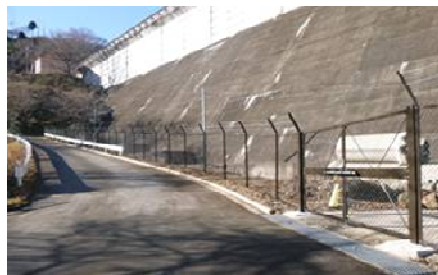
写真一 立入防止柵及び門扉
