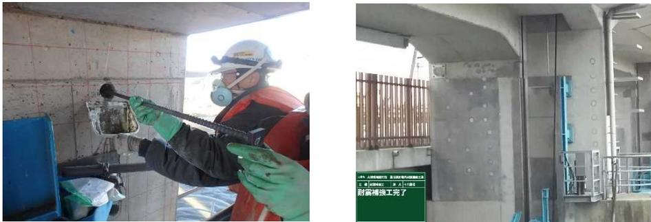
写真-2 耐震補強工事実施状況 (左:堰柱鉄筋挿入、右:完成)
