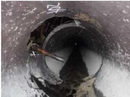
写真-3 PC管損傷状況
