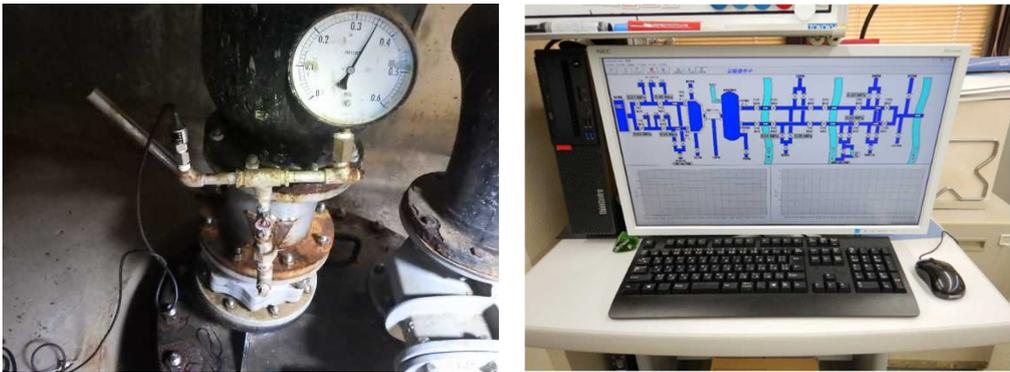
写真-3 震ヶ浦用水 (左: 圧力センサ設置状況、右: 圧力監視装置)
