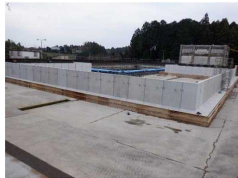
写真-8 改築工事実施状況 (左:制水弁更新工事 右:吸水槽分画化工事)
