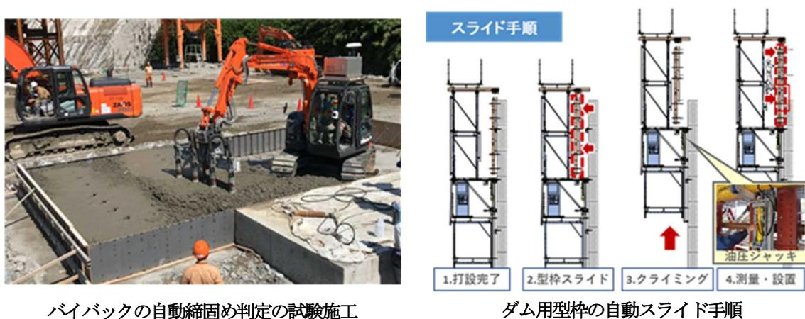
パイバックの自動締固め判定の試験施工
