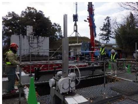
写真-9 管内調査に向けた通水切替 (仮締切工設置状況)
