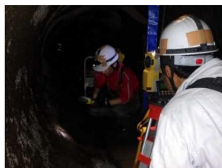
写真-2 機能診断調査（管路）の実施状況
