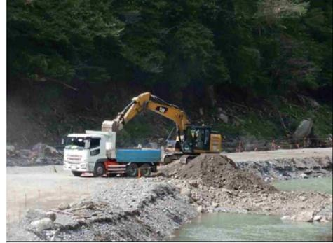
写真-4 下久保ダムにおける災害復旧工事（堆砂除去）実施状況
