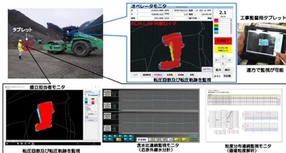
図-2 施工状況のリアルタイム監視
