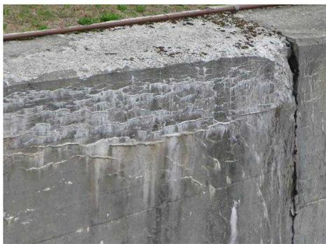
写真-1 凍害劣化した洪水吐き導流壁
