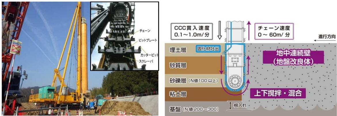
写真-6 CCC工法の施工状況と改良体造成概要
