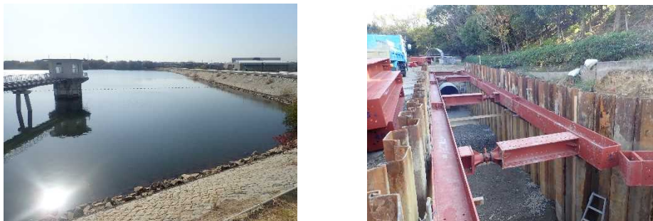
写真-6 改築工事実施概要（左：三好池大規模耐震対策[完成]、右：三好支線水路改築）
