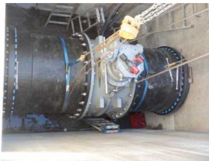
写真-8 改築工事実施状況(左：制水弁更新工事、右：ファームポンド分画化工事)
