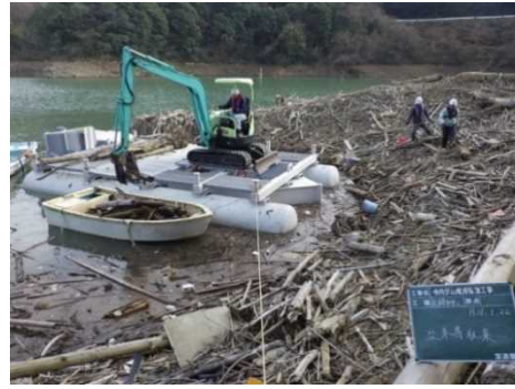
(流木撤去状況)
