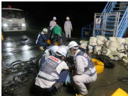
ポンプ車 60m 3 /min排水作業 (川添水門)
