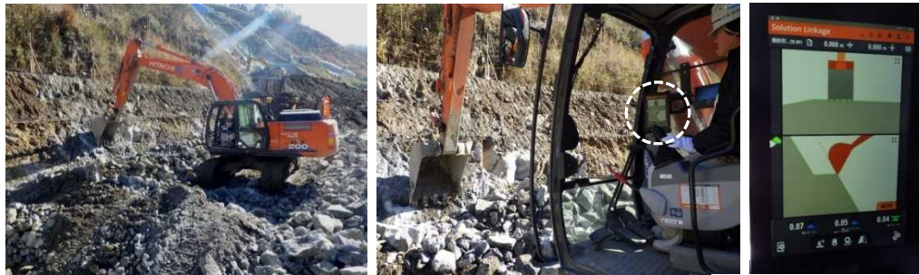
(a) 掘削作業状況
