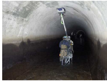
写真-5 機能診断調査（トンネル）の実施状況 （令和3年度：群馬用水）
