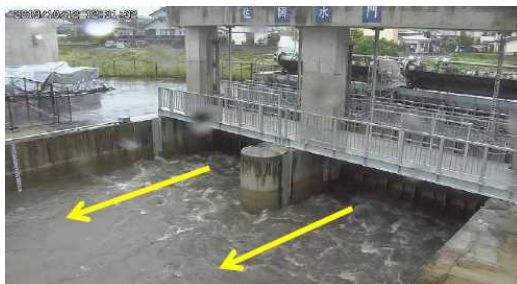
武蔵水路への洪水取込状況 (佐間水門)
