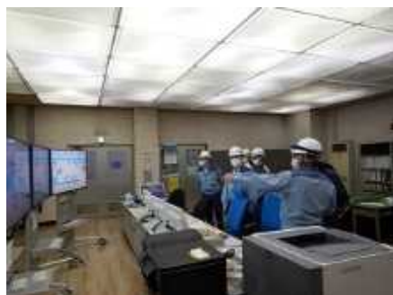
左：操作室監視設備概要
