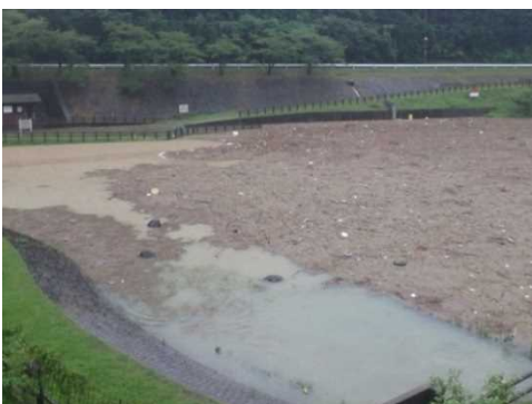
(貯水池内流木堆積状況)
