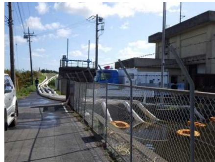
排水作業状況（屋形排水機場）
