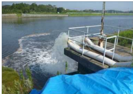
排水作業状況（東部排水機場）
