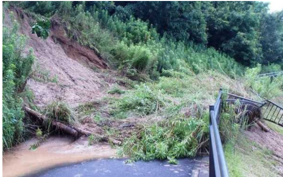
(法面崩落状況)
