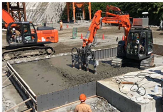
<バイバックの自動締固め判定の試験施工>
