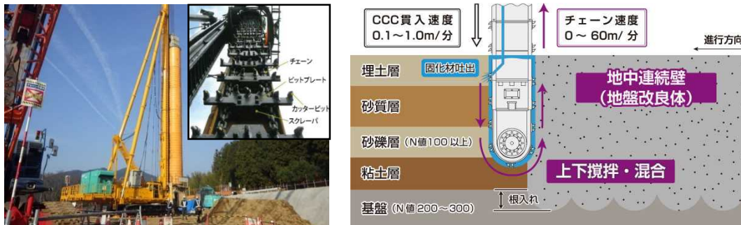
写真-10 CCC工法の施工状況と改良体造成概要
