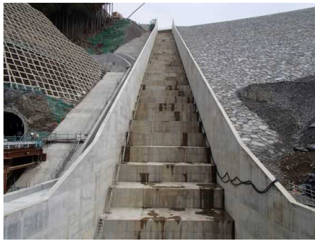
写真-7 採用した階段式の洪水吐き
