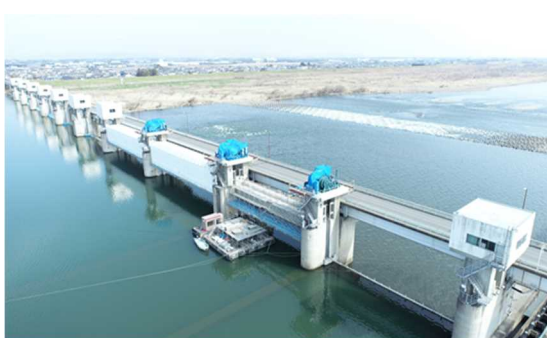
写真-13 利根大堰開閉装置更新実施状況 (左・右：開閉器更新状況)
