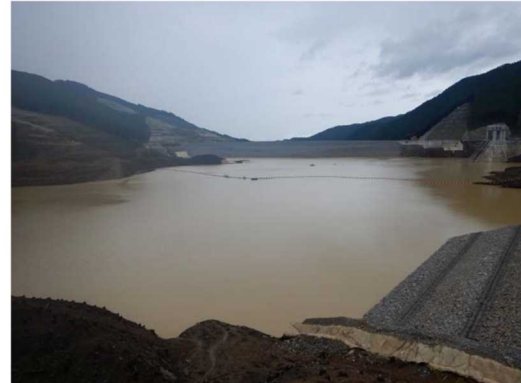
撮影日時：令和3年8月16日 14時 撮影時の貯水位：EL.326.44m
