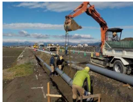
写真-9 機能保全対策（敷設替え）の実施状況 （令和2年度：木曾川用水）
