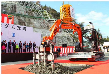
(無人化機械によるコンクリート締固め)
