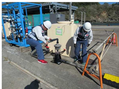
可搬式浄水装置設置状況
