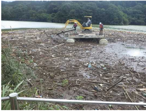
(貯水池内流木堆積状況)
