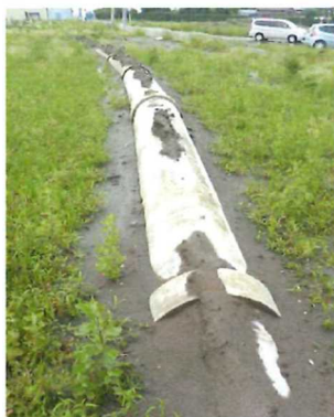
液状化によるパイプラインの浮上
