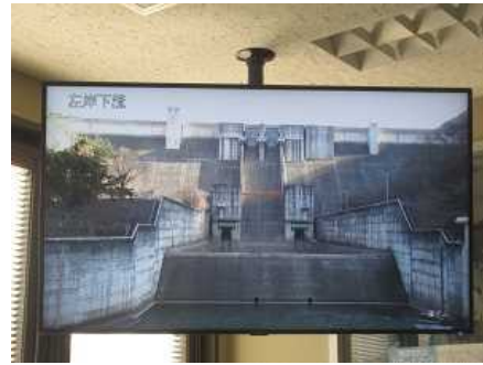
一庫ダム監視モニター（更新後）
