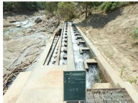
(魚道の堆砂・流木撤去後)
