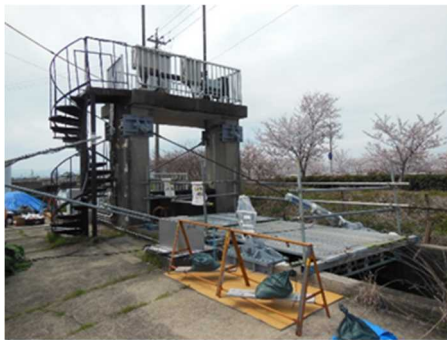
写真-1 実証実験施設(木曾川用水調節堰)
