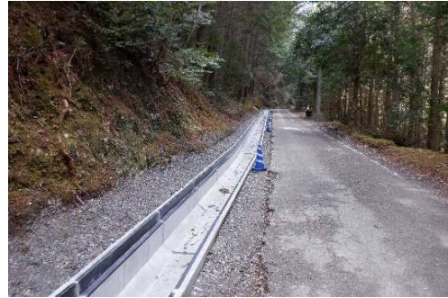
(準備工事：排水施設工事)
