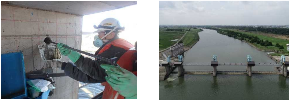
写真-2 耐震補強工事実施状況（左：取水樋門鉄筋挿入、右：完成）
