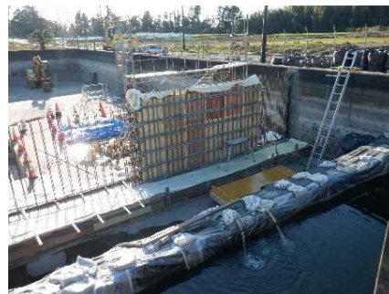
写真-8 改築工事実施状況(左：制水弁更新工事、右：ファームポンド分画化工事)
