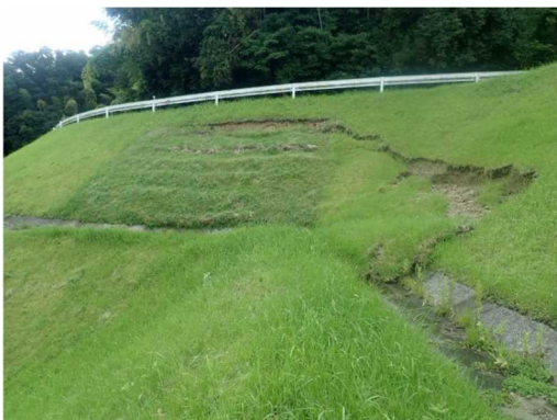
(法面崩落状況)
