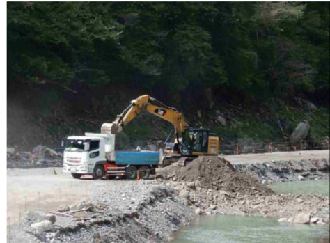
写真-5 下久保ダムにおける災害復旧工事(堆砂除去)実施状況
