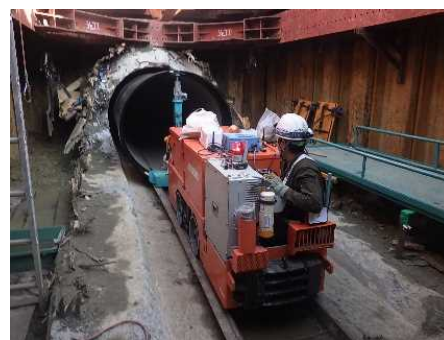
写真-9 水路改築工事実施状況(左：鋼管挿入、右：ダクタイル鋳鉄管挿入)
