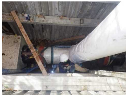
写真-8 機能保全対策（管更生）の実施状況 （令和元年度：三重用水）
