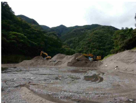
写真-5 下久保ダムにおける災害復旧工事(堆砂除去)実施状況
