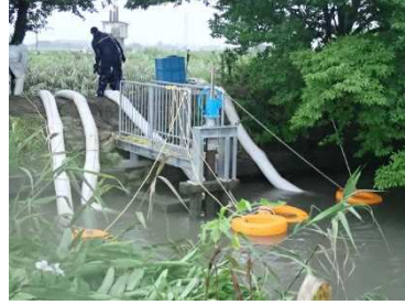
ポンプ設置状況
