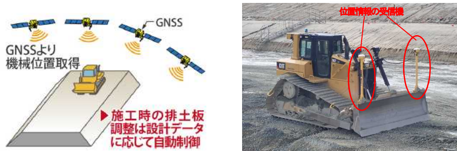
写真-1 GNSSを用いた盛立（層厚）管理
