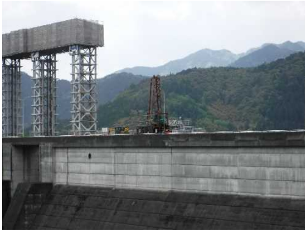
(準備工事：観測設備(プラムライン)移設工事)
