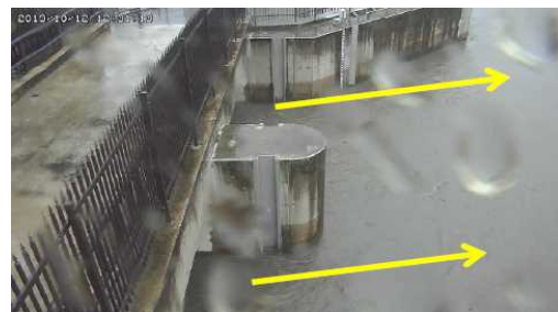
武蔵水路への洪水取込状況 (川面水門)
