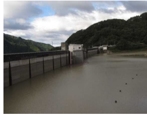
洪水後の貯水池の状況 (10月13日8時00分頃 E.L. 446.72m)
