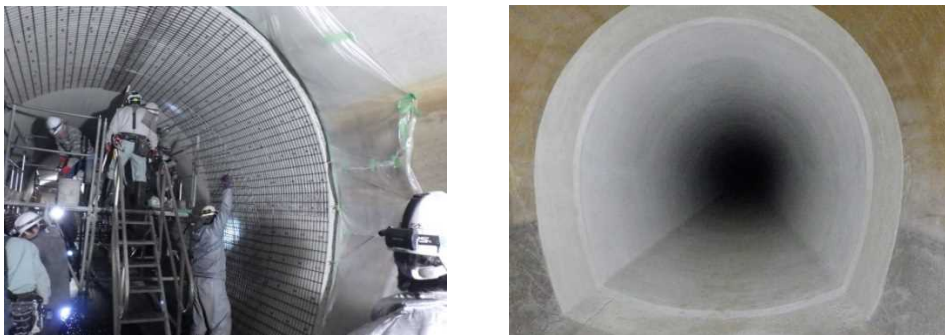
写真-3 トンネル改築工事実施状況（左：耐震補強、右：完成）
