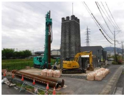
写真-7 耐震補強工事実施状況
