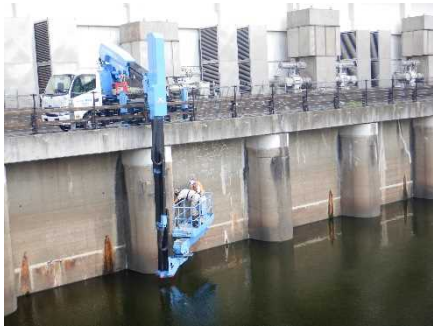
写真-4 機能診断調査（機場）の実施状況 （令和3年度：群馬用水）
