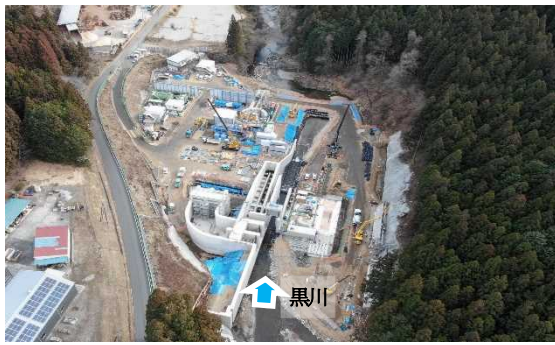
(導水路工事：黒川取水放流工施工状況)
