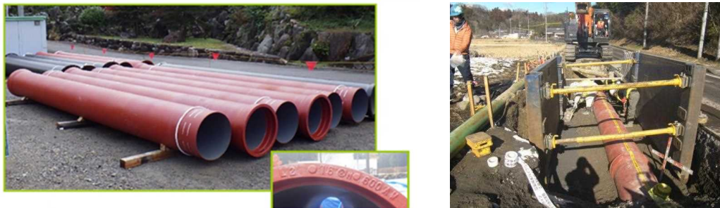
ALW形管の施工状況
