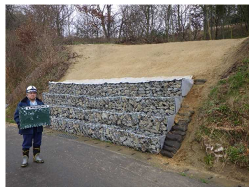
(法面復旧状況)
