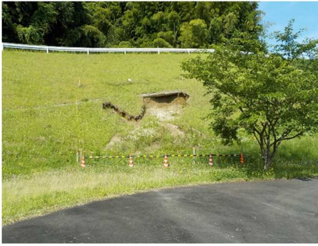
(法面崩落状況)
