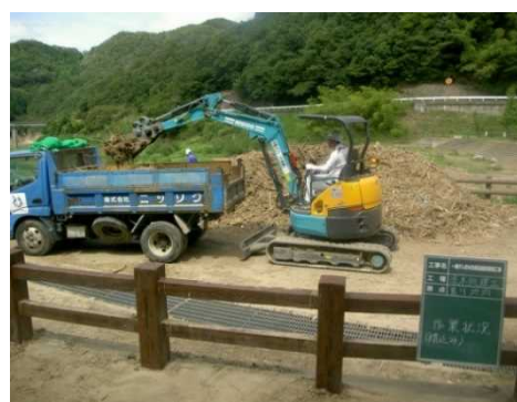
(流木撤去状況)
