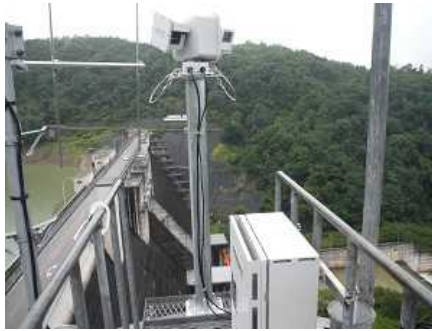
一庫ダム監視カメラ（更新後）
