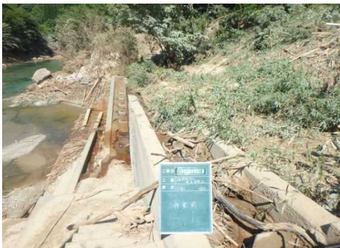
(魚道の堆砂・流木堆積状況)
