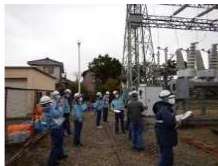
右：特高変電所受電操作
