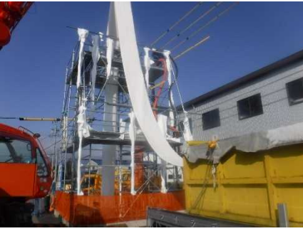
写真-11 機能保全対策（管更生）の実施状況 （令和3年度：三重用水）
