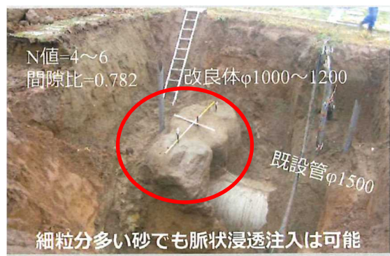
既設管路の浮上防止構造
