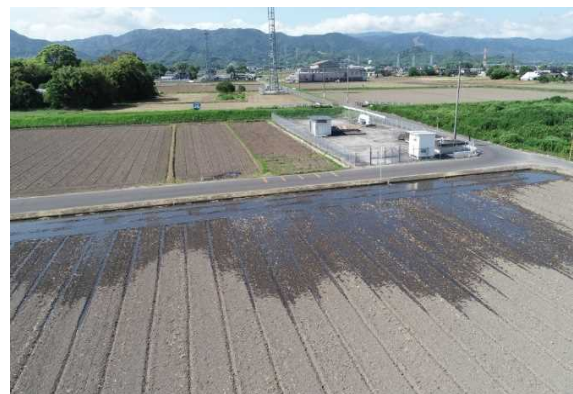
渇水期間中の代かき用水の注水
