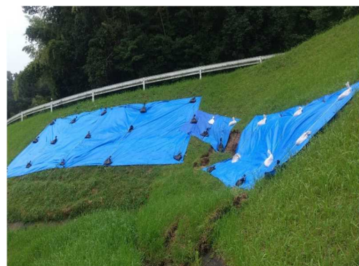
(法面応急復旧状況)
