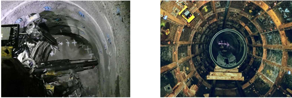
写真-4 併設水路工事実施状況
