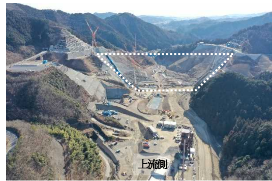
(ダムサイト施工状況)
