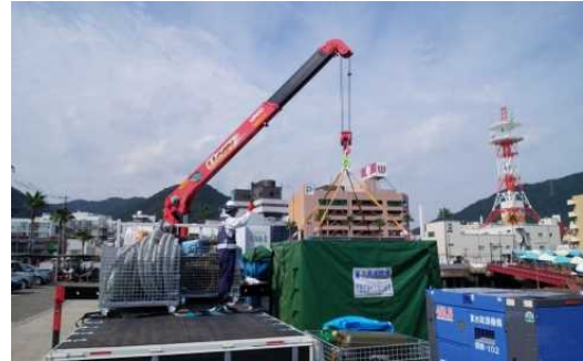
可搬式浄水装置設置状況
