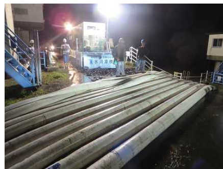
ポンプ車 60m 3 /min排水作業 (川添水門)
