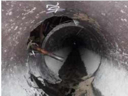
写真-4 PC管損傷状況
