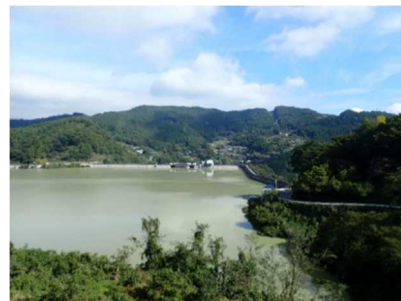
洪水後の貯水池の状況 (10月17日10時00分頃 E L. 295.86m)
