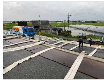
60m 3 /minポンプ車排水作業
