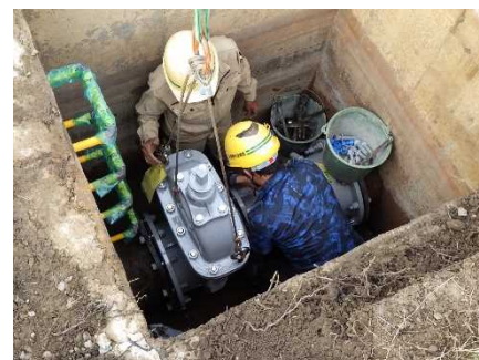
写真-10 機能保全対策（制水弁据付）の実施状況 （令和3年度：木曾川用水）
