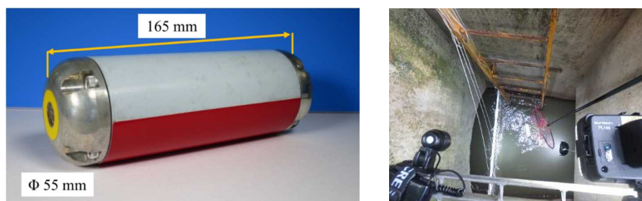
写真-3 木曽川用水 (木曽川右岸施設) (左: 漏水探査ロボット、右: 漏水探査ロボット回収状況)
