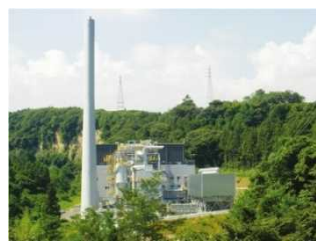
バイオマス発電施設 ※1
