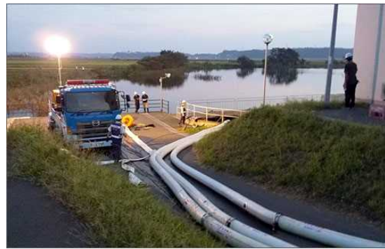
排水作業状況（宗吾北機場）
