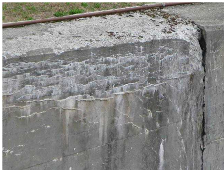
写真-1 凍害劣化した洪水吐き導流壁 図-3 内部状況解析結果(左:旧吉野川河口堰、右:寺内ダム)
