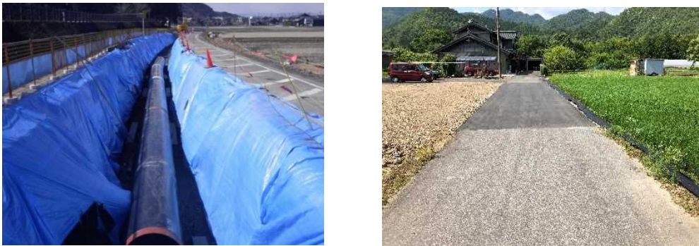
写真-5 改築工事実施状況（左：左岸幹線水路管路敷設替え、右：完成）
