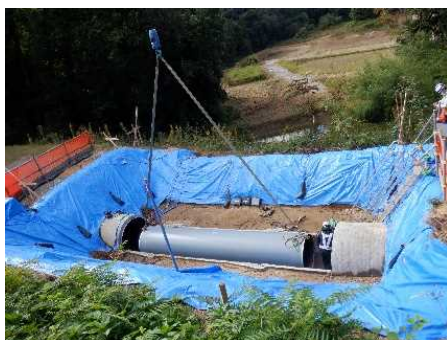
写真-9 水路改築工事実施状況(左：鋼管挿入、右：ダクタイル鋳鉄管挿入)
