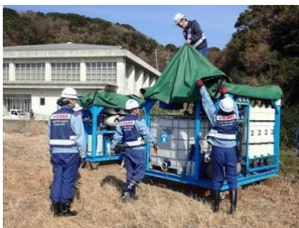
可搬式浄水装置設置状況
