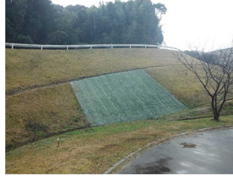
(法面復旧状況)
