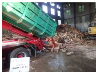
チップ化施設への搬入状況
