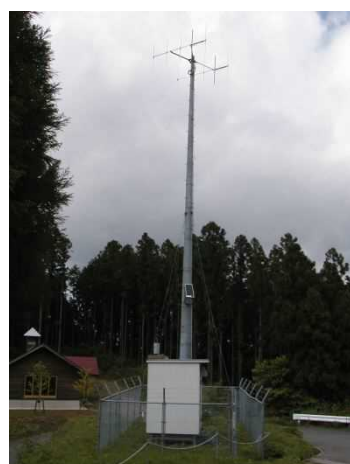
写真-1 雨量観測設備
