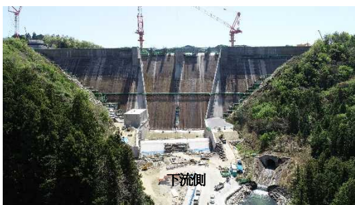
(コンクリート打設完了(令和3年4月))
