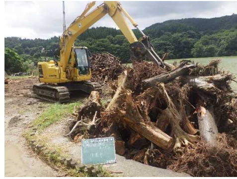
(流木撤去状況)
