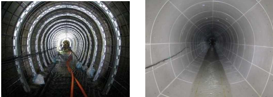
写真-1 有馬トンネル補強工事状況（左：内巻補強工、右：完成）
