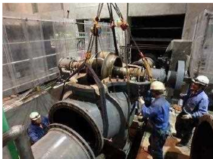
写真-12 機械設備整備状況 (左：横芝揚水機場ポンプ設備改修、右：大網揚水機場ポンプ設備改修)
