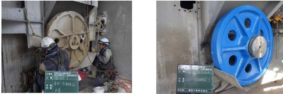
写真-13 利根大堰扉体ローラ取替え実施状況（左：扉体ローラ撤去状況、右：更新後の扉体ローラ）
