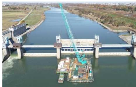
写真－1 耐震補強工事実施状況（左：利根大堰、右：秋ヶ瀬取水堰）
