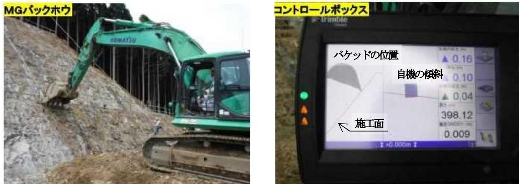
写真-9 マシンガイダンス付きバックホウによる基礎掘削
