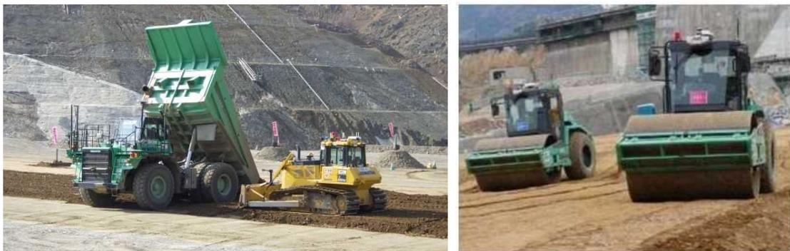
写真-10 無人による自動化運転の試行
