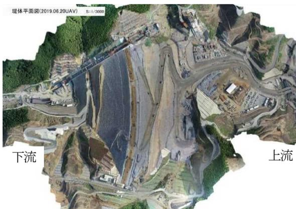
写真-7 工程遅延回復策(腹付け盛土の大型化)
