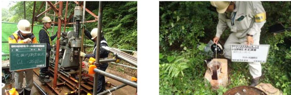
写真-6 2号トンネル併設水路調査状況（左：地質調査、右：水文調査）
