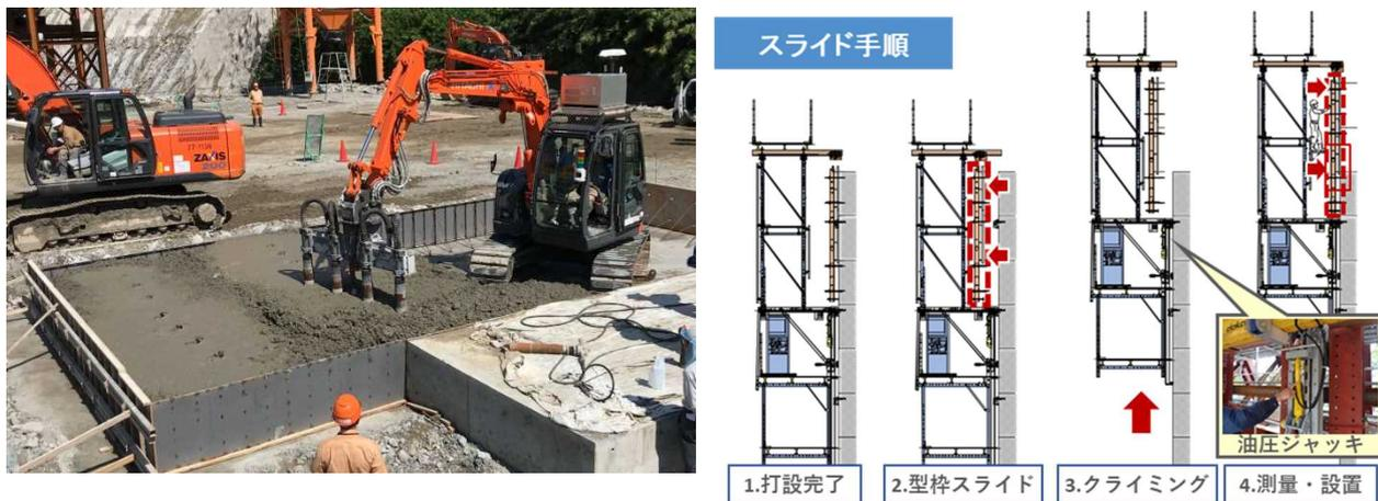
パイバックの自動締め固め判定の試験施工
