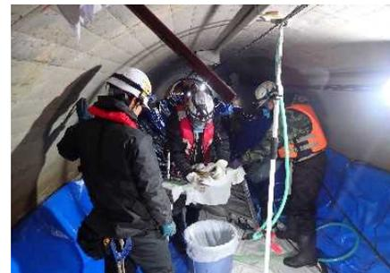
写真-4 改築工事实施状況（左：左岸幹線水路鋼管布設、右：白川導水路白宗トンネル空洞充填）
