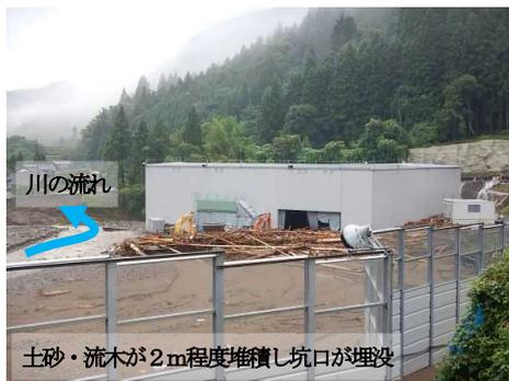
写真-6 豪雨による被災(導水路取水工坑口の閉塞)
