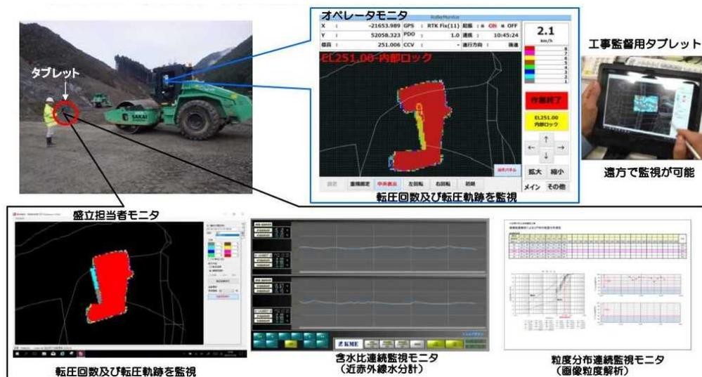
図-3 施工状況のリアルタイム監視
