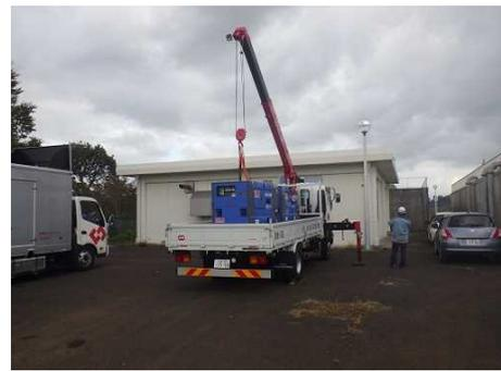
写真-12 発動発電機設置状況 (久賀第1取水井)
