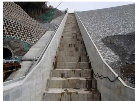
写真-8 採用した階段式の洪水吐
