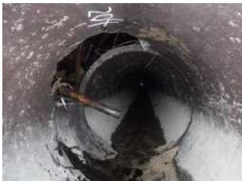
写真-12 PC管損傷状況
