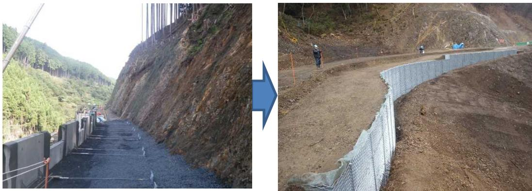
写真-14 工法の比較 (左：従来の補強土壁、右：鋼製L型擁壁 (西ノ入工区))
