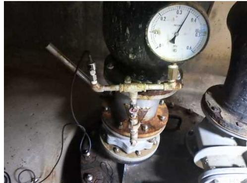
写真-3 霞ヶ浦用水(左:圧力センサとデータロガー、右:圧力センサ設置状況)
