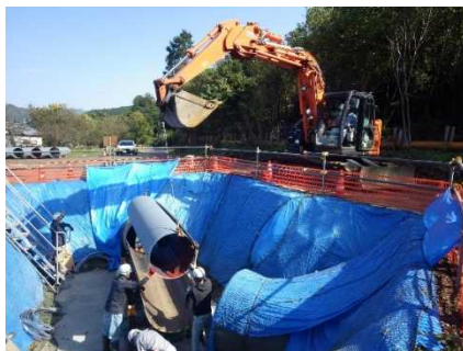
写真-4 改築工事実施状況（左：左岸幹線水路鋼管布設、右：幹線用水路ダクタイル鋳鉄管布設）
