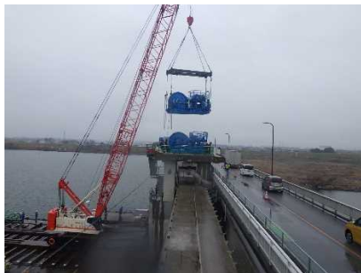
写真-11 利根大堰開閉装置更新実施状況(左:開閉装置据付状況、右:更新後の開閉装置)
