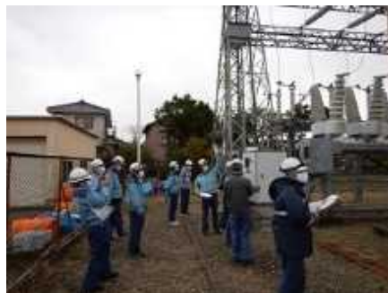
特高変電所受電操作（千葉用水総合管理所）
