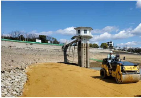
写真-6 ICT建設機械による締固め状況
