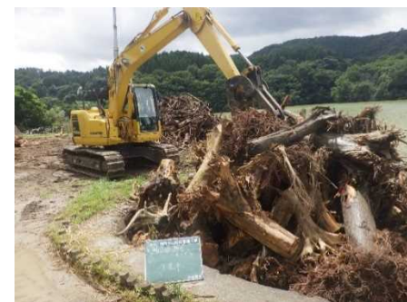
流木撤去状況
