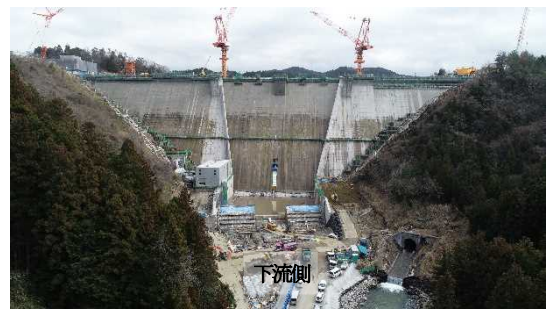
(コンクリート打設中 (令和3年3月))
