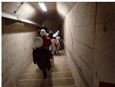
(浦山ダム 監査廊 見学状況)
