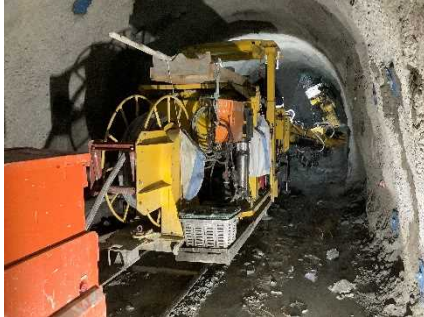
写真-3 併設水路工事実施状況 （左：トンネル掘削（NATM工法）、右：トンネル掘削（シールド工法）
