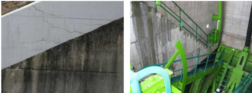
写真-2 健全性評価技術の高度化に関する実証実験箇所（寺内ダム）
