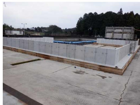
写真-7 改築工事実施状況 (左: 制水弁更新工事 右: 吸水槽分画化工事)
