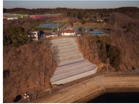
（法面復旧状況）
