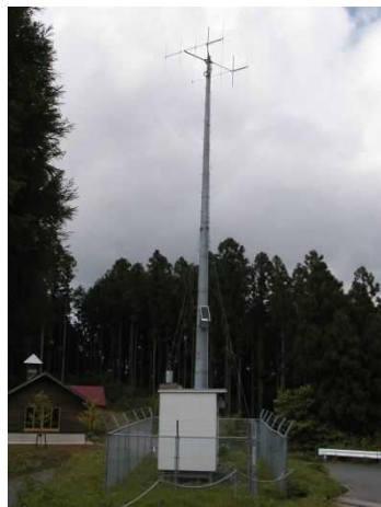
写真-1 雨量観測設備
