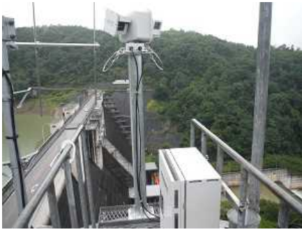
一庫ダム監視カメラ（更新後）
