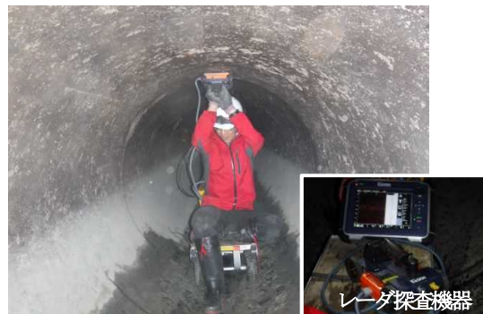
写真-5 電磁波レーダ探査法による調査実施状況
