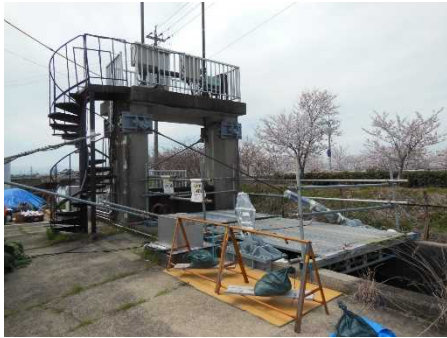
写真-1 実証試験施設(木曾川用水調節堰)
