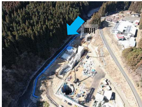
(導水路工事：黒川取水放流工施工状況)
