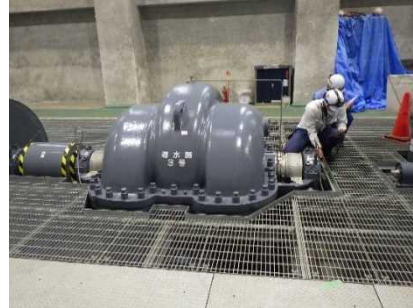
写真-10 総合試運転実施状況(左:大網操作室シーケンス確認作業、右:横芝ポンプ軸受振動測定)
