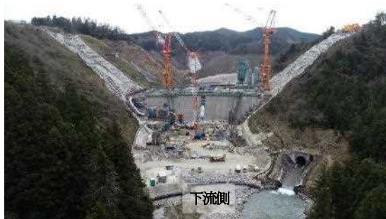
(コンクリート打設中 (令和2年4月))
