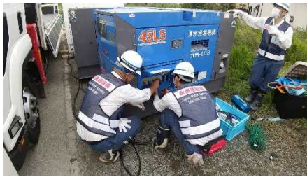
排水ポンプ設置状況
