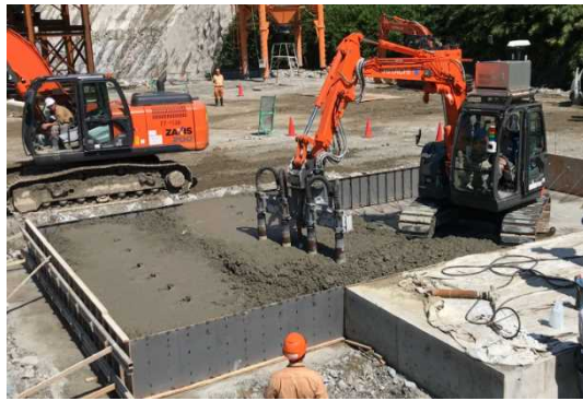
バックの自動締め判定の試験施工
