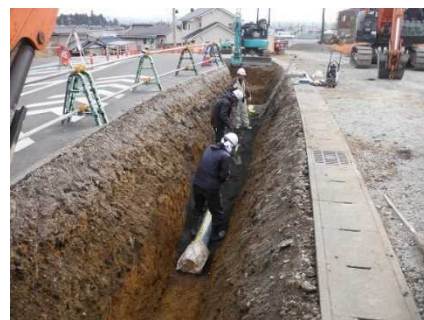
写真-4 改築工事実施状況（左：左岸幹線水路鋼管布設、右：幹線用水路ダクタイル鋳鉄管布設）
