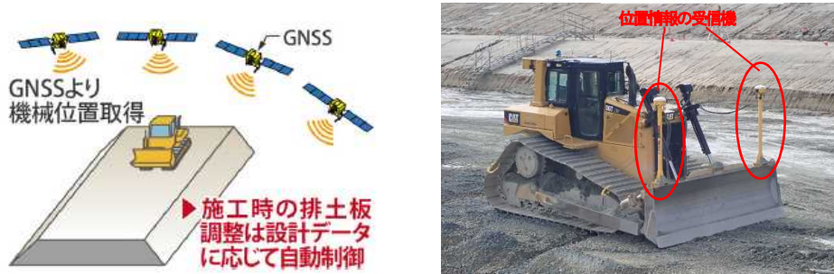
写真-2 GNSSを用いた盛立（層厚）管理
