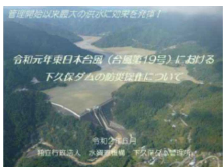
小冊子「令和元年東日本台風における下久保ダムの防災操作について」
