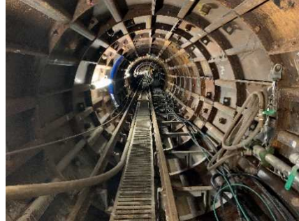
写真-3 併設水路工事実施状況 （左：トンネル掘削（NATM工法）、右：トンネル掘削（シールド工法）
