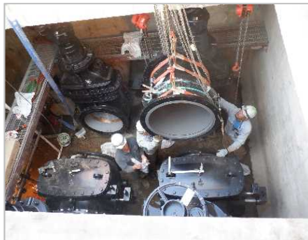
写真-7 改築工事実施状況 (左: 制水弁更新工事 右: 吸水槽分画化工事)
