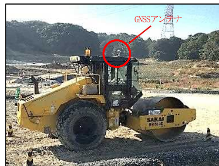
写真-3 GNSSを用いた締固め管理
