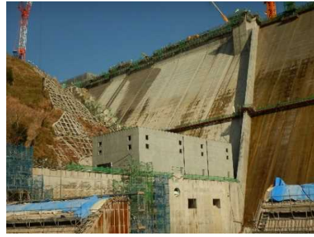
写真-6 発電所建屋
