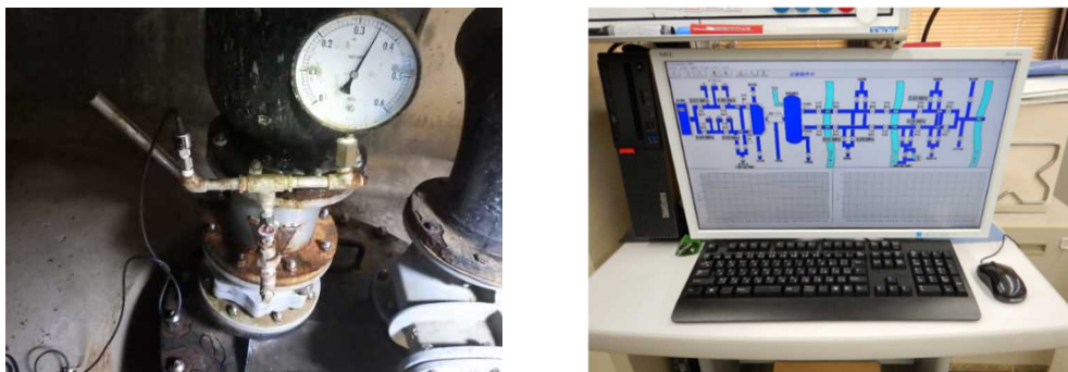
写真-2 霞ヶ浦用水(左:圧力センサ設置状況、右:圧力監視装置)
