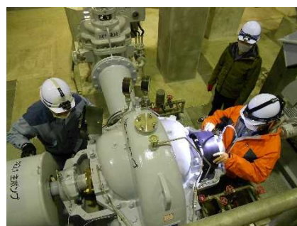
現地研修会（筑後川下流用水ポンプ設備）
