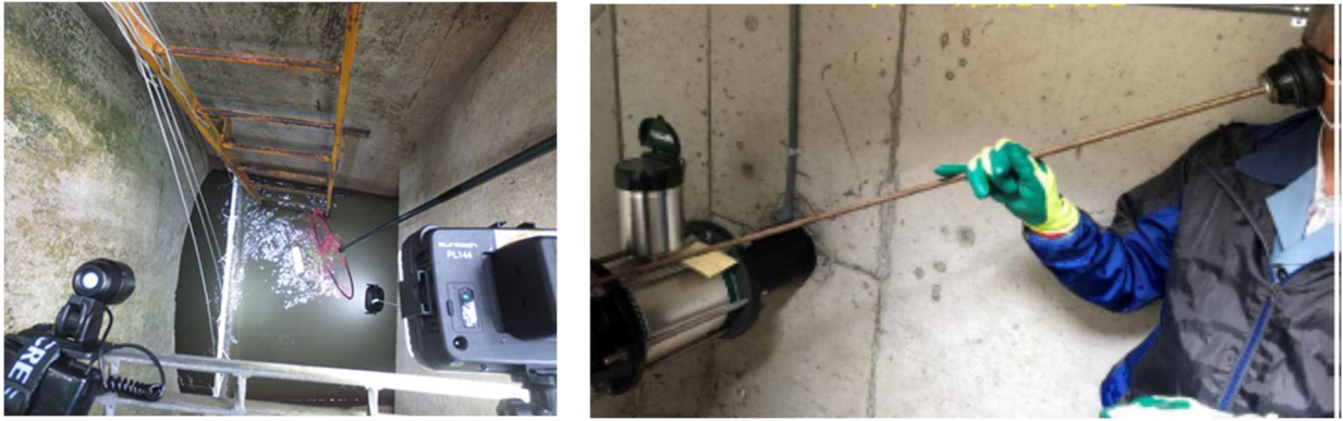
写真-3 木曽川用水（漏水探査ロボットの流下試験）
