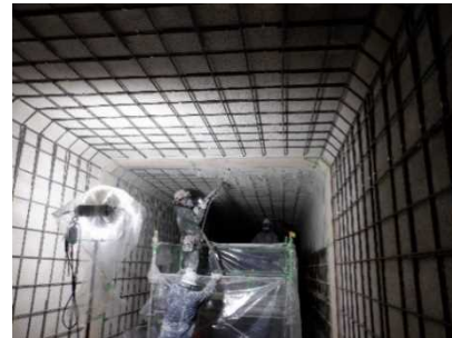
写真-1 耐震補強工事実施状況（左：利根大堰、右：朝霞水路）
