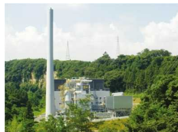
バイオマス発電施設*1
