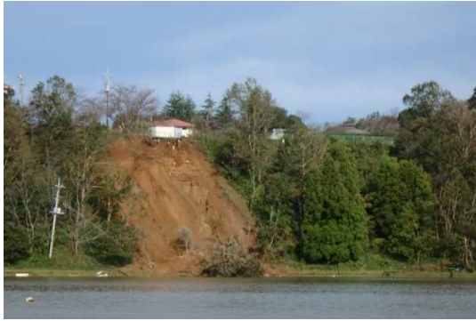
（法面崩落状況）
