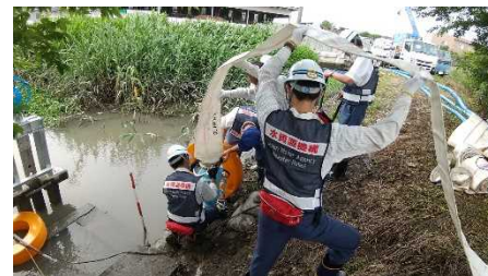
排水ポンプ設置状況
