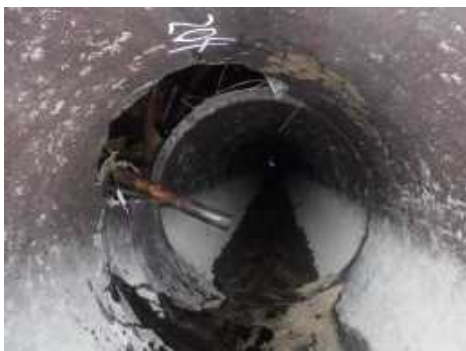
写真-4 PC管損傷状況
