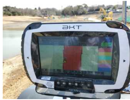
写真-7 締固め確認モニター
