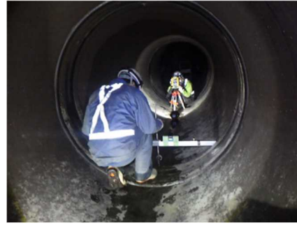
写真-8 対策工事実施状況（左：管内調査に向けた通水切替（仮締切工設置状況） 右：管内調査状況）
