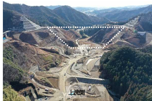
(ダムサイト施工状況)
