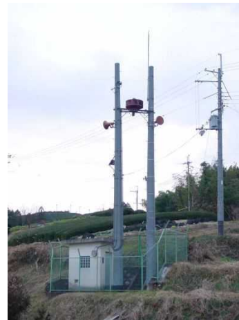
写真-2 警報設備
