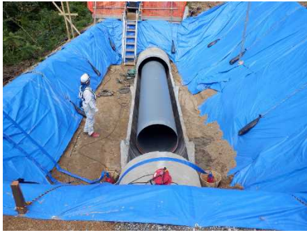
写真－5 改築・耐震補強工事实施状況（左：鋼管布設状況、右：耐震対策状況）
