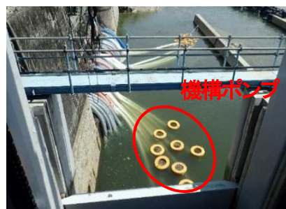
ポンプ車による緊急取水
