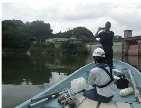
写真-1 船舶による巡視 (室生ダム)
