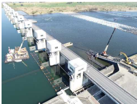
写真－1 耐震補強工事实施状況（左：利根大堰、右：朝霞水路）
