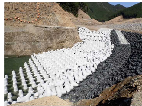
(河床水路の復旧状況)
