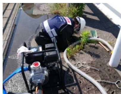
空気弁からの漏水対応
