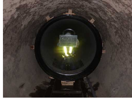
写真－5 改築・耐震補強工事实施状況（左：鋼管布設状況、右：耐震対策状況）
