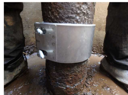
写真－8 漏水事故発生状況（左：漏水した空気弁工、右：漏水箇所の補修状況）
