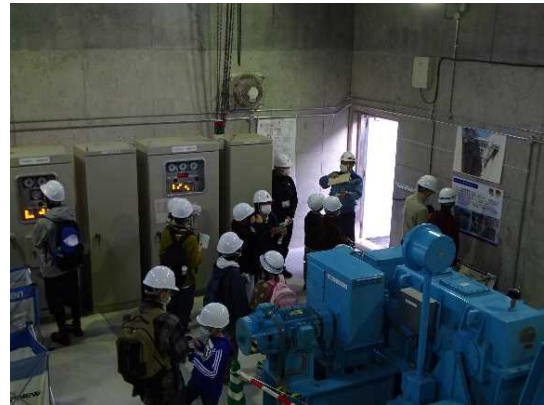
写真－4 クレストゲート室の見学状況
