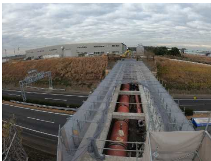
写真－2 改築工事实施状況（左：幹線水路、右：小泉揚水機場中継水槽）
