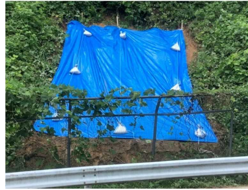
(法面応急復旧状況)
