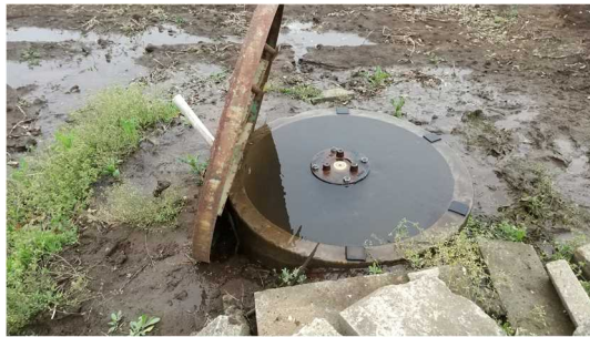
写真－8 漏水事故発生状況（左：漏水した空気弁工、右：漏水箇所の補修状況）
