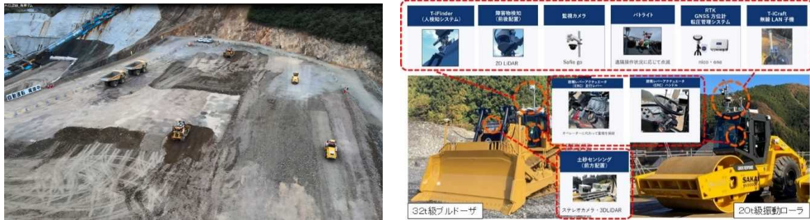
写真-5 ダム建設現場における自動制御型重機による無人化施工の試行運転
