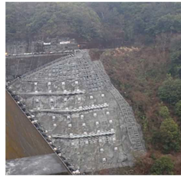
(法面復旧状況)
