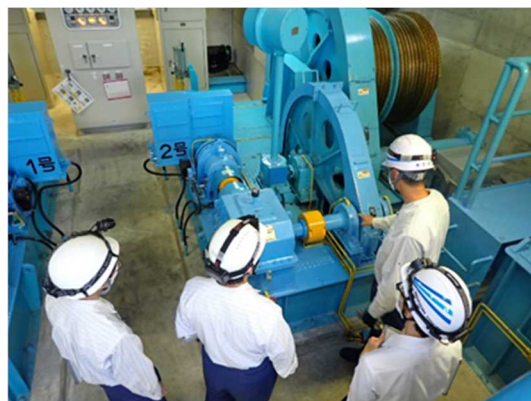
写真-7 機械設備点検におけるOJTの実施状況
