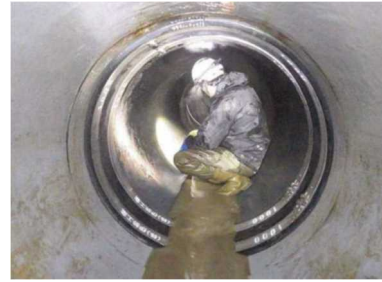
継手補強材設置状況
