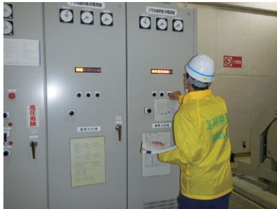
受変電設備の動作確認 (早明浦ダム)
