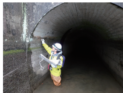
水路トンネルの点検(両筑平野用水)
