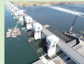
耐震補強工事中の利根大堰
