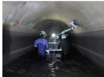
(左:通水点検装置車による背面画像撮影、右:通水台車による背面空洞調査)
