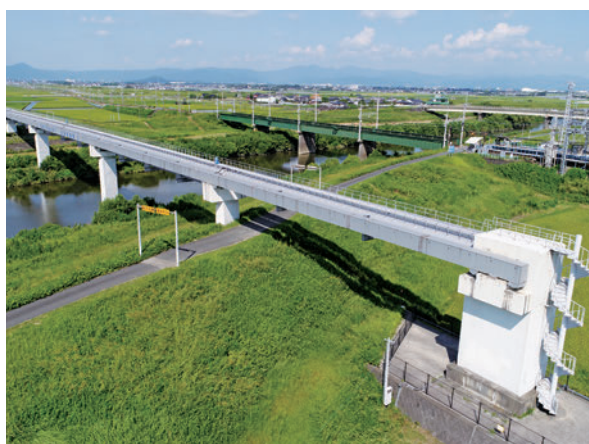
福岡導水施設地震対策
