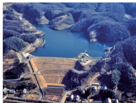
はちや 木曽川用水（蜂屋調整池）
