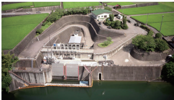
香川用水（取水工）
