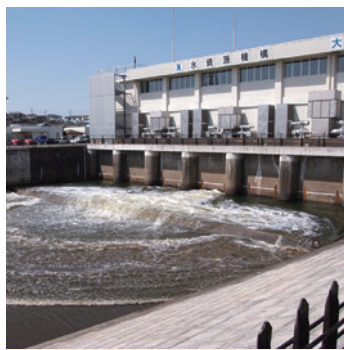
印旛沼開発 (大和田機場)
