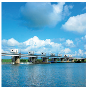
利根導水路 (利根大堰)
