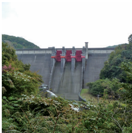
室生ダム (室生湖)
