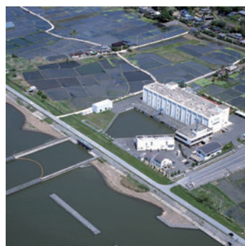
霞ヶ浦用水 (揚水機場)
