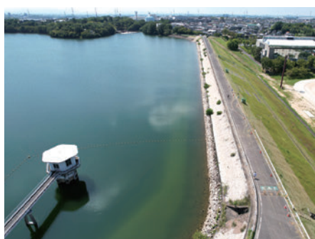
愛知用水三好支線水路緊急対策
