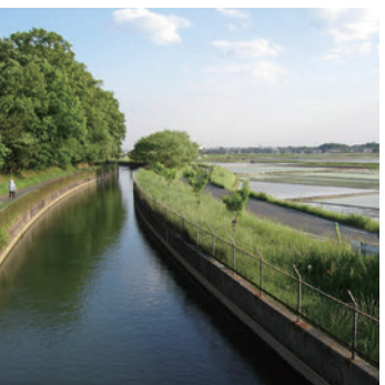
ごうくち みぬまきかんせん 埼玉合口二期 (見沼基幹線水路)
