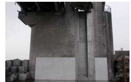
ポリマーセメントモルタルによる補強(堰柱部)
