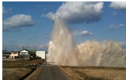
老朽化により破断した管水路(左:香川用水、右:木曽川用水)
