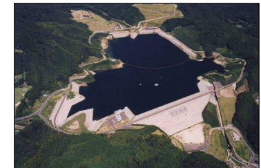
福岡導水 山口調整池
