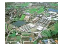
県央第1水道事務所
