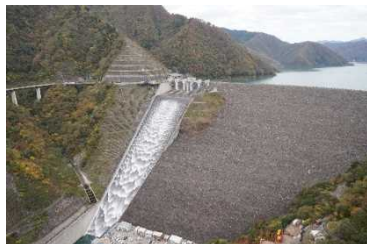
徳山ダム(特定施設)
