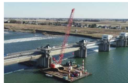
堰の耐震対策(利根大堰)
