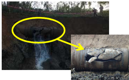
老朽化により破断した管水路(左:香川用水、右:木曽川用水)
