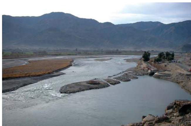
マルワリード用水路取水堰
