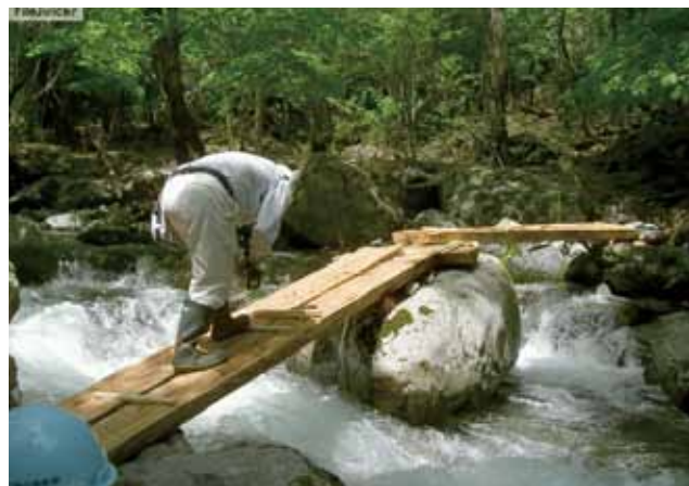
赤西溪谷「水源の森」づくり、仮橋架橋
