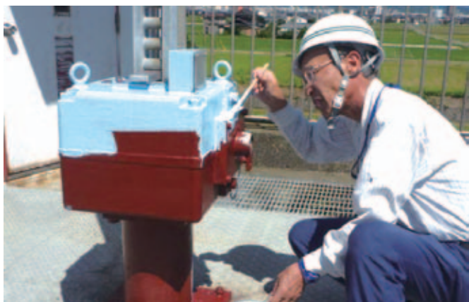
ゲート巻き上げ機の塗装
