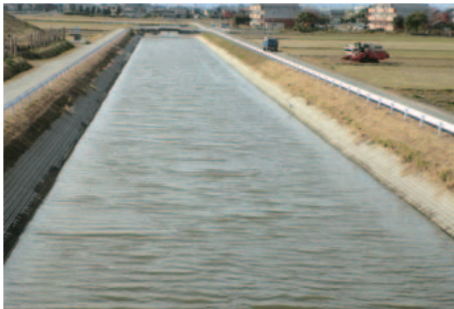
国営水路（筑後川下流土地改良事業）
