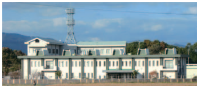
筑後揚水機場（水資源機構）
