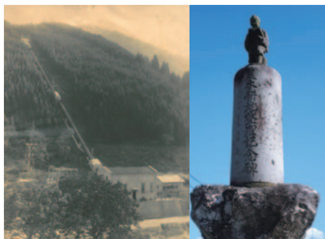
矢部川発電所
