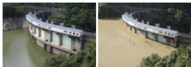
高山ダム 平常時管理水位EL116.0m (平成25年9月24日)
