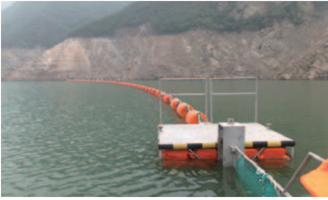
プロジェクトによって黒河金盆ダム湖に設置された網場と通船ゲート
