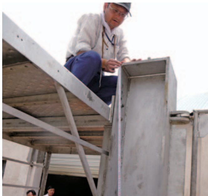
通船ゲートの工場検査
