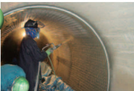
トンネル増厚吹き付け工事
