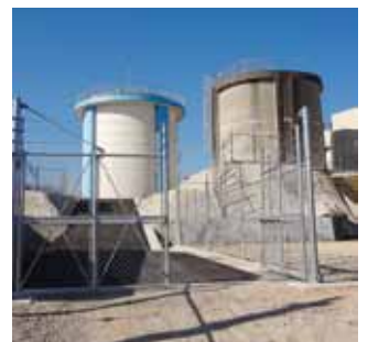
日間賀島配水池
