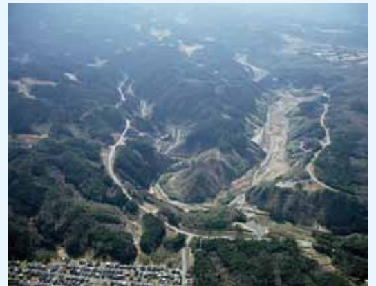
川上ダム建設予定地
