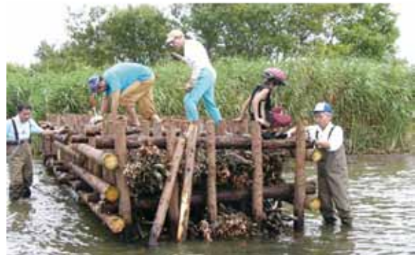
【粗朶消波工設置状況】
