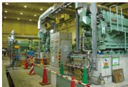
糠田排水機場
