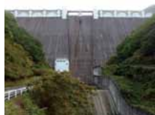
ダム（浦山ダム）
