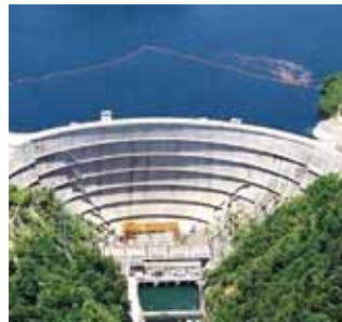
アーチ式（矢木沢ダム）
