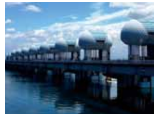
堰（長良川河口堰）
