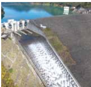
ゾーン型（徳山ダム）
