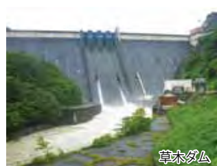
ダムが洪水を貯める様子(左)と下流に流す水を少なくする様子
