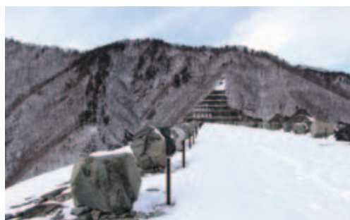
奈良俣ダム (平成28年2月)
