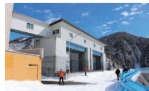
矢木沢ダム (平成28年2月)
