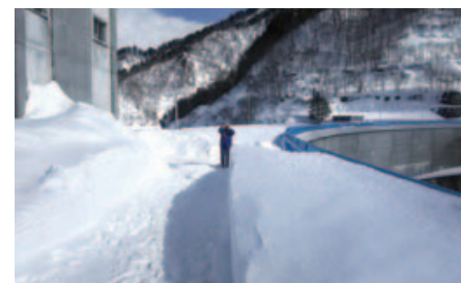
矢木沢ダム (平成29年2月)
