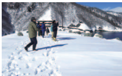
奈良俣ダム (平成29年2月)
