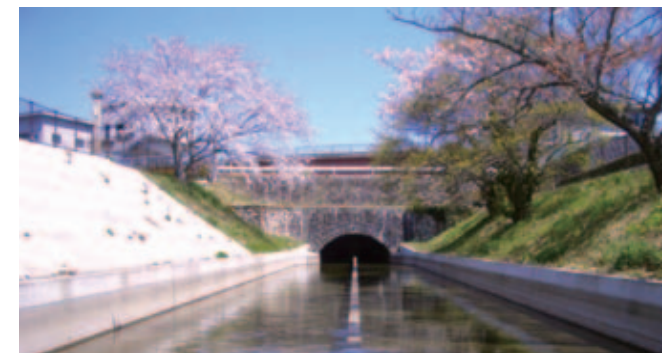
現在の第一号樋管:下流から撮影
