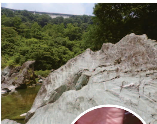
銘石、袖石を望む 下久保ダム
