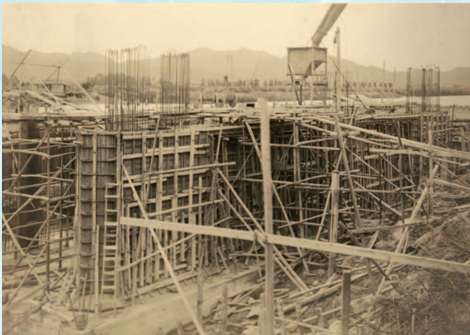
潮止め樋門建設状況
