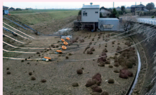
排水が完了した浸水エリア
