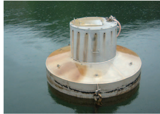
曝気循環設備 (排気口)
