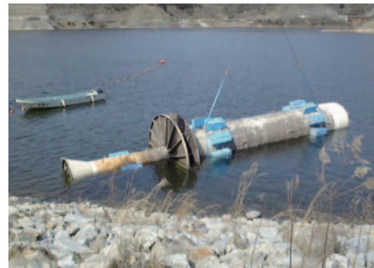
曝気循環設備 (本体)
