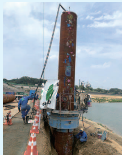
カラフルな鋼管杭が打設されていく様子
