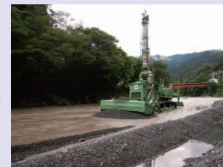
土砂を除去する水陸両用ブルドーザー
