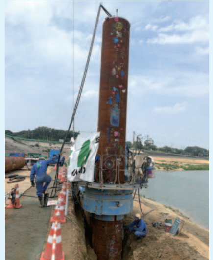
カラフルな鋼管杭が打設されていく様子
