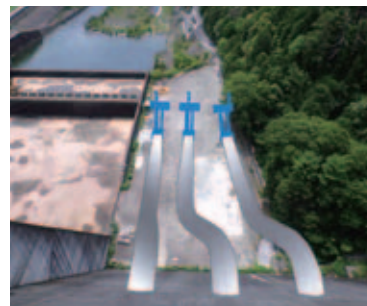
堤体穴空け(上から)
