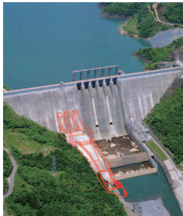
放流設備・減勢工増設
