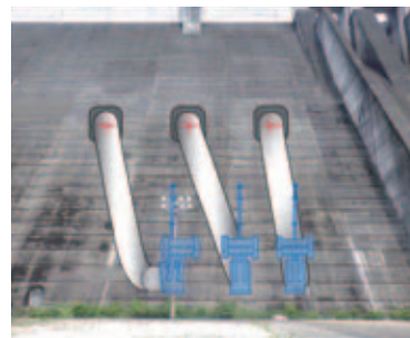
堤体穴空け(下から)
