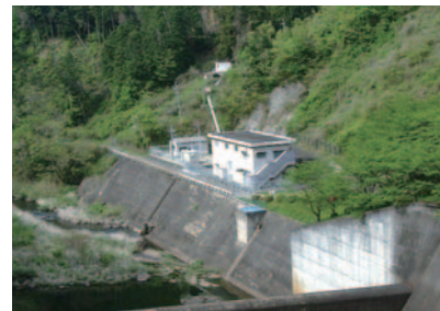
青蓮寺発電所
