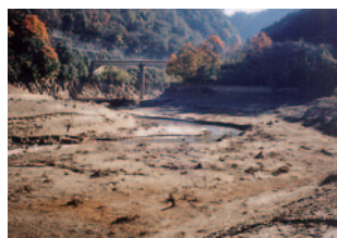
香落橋状況(平成6年)
