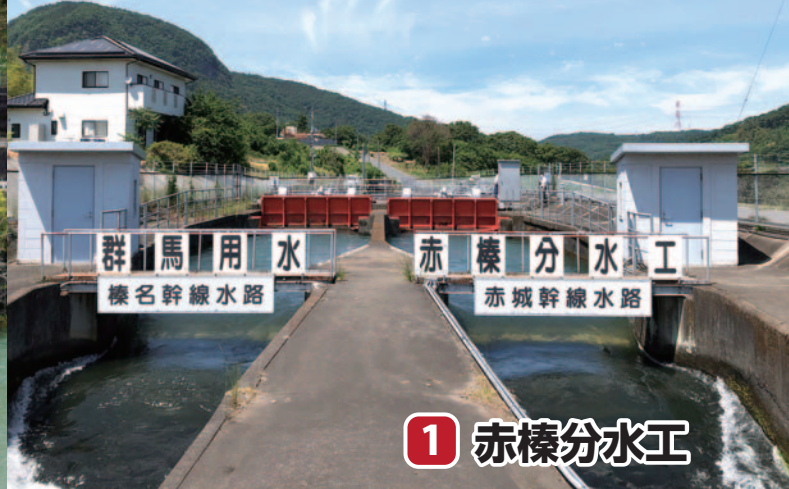
1 取水口(綾戸取水口)
