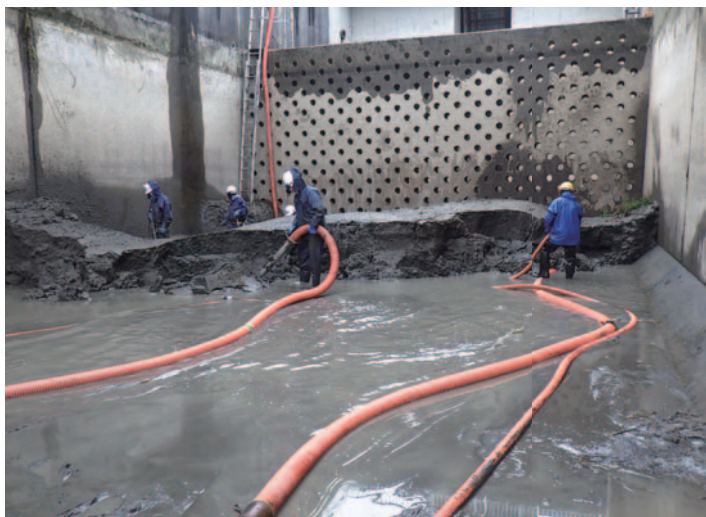
▲沈砂池の土砂撤去状況
