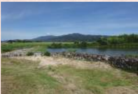
嘉瀬川本流を堰止める 石井樋の大井出堰(佐賀県佐賀市)
