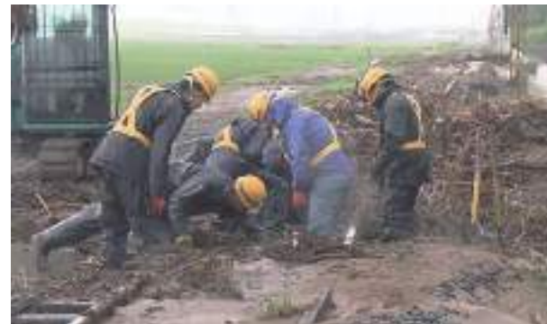
7月7日 土砂が流入した線路(出雲市)
