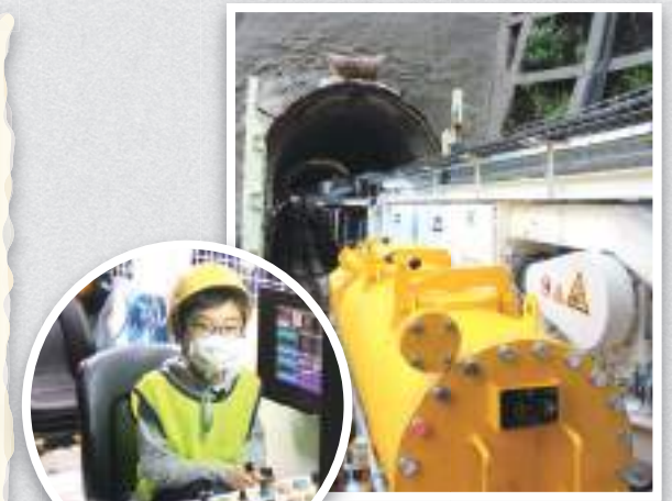
南摩ダムに貯めた水を黒川、大芦川に送る「送水路」の掘削工事で使用するTBM(トンネルボーリングマシン)
