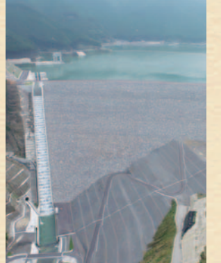
小石原川ダム (福岡県朝倉市)
