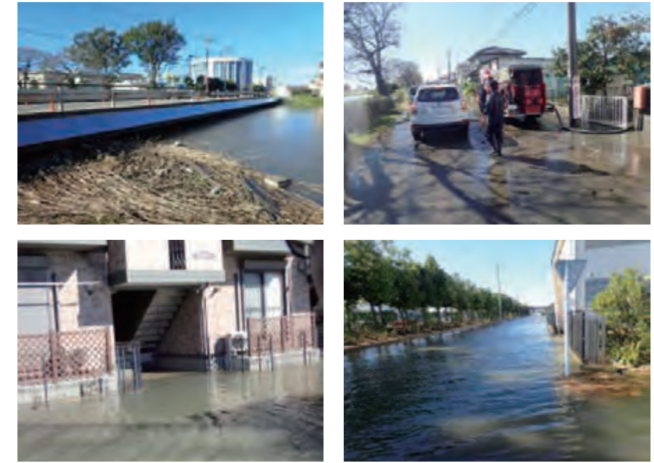
行田市内の被害状況
