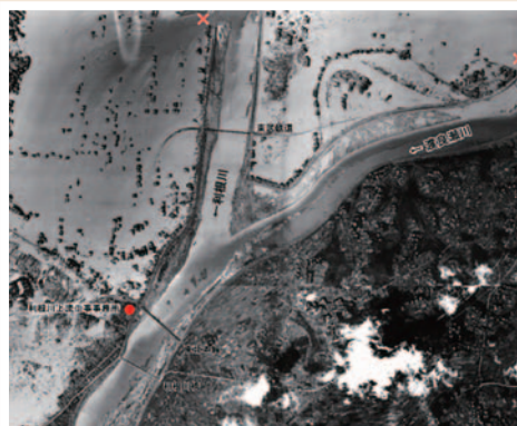
破堤箇所の航空写真
