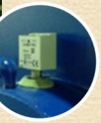
更新した電動機には、TR-COMというIoTを駆使した監視装置を取り付けています。これにより、いつでもどこでも振動と温度を監視できるようになりました。
