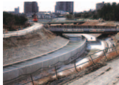
愛知用水(改築中の白山開水路)
