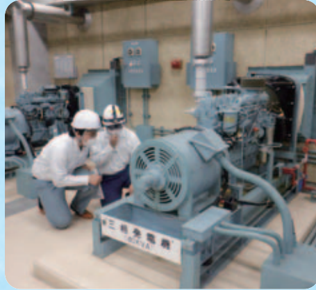
発電設備の点検に同行しました。
