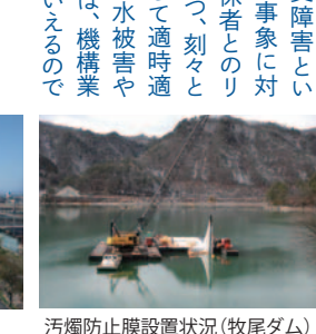
汚濁防止膜設置状況(牧尾ダム)
