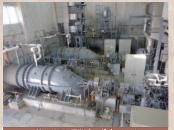
新附洲開門機場内の排水ポンプ
