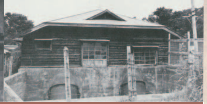
附洲排水機場(昭和17年完成) 出典：香北のあゆみ
