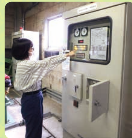
常用洪水吐予備ゲートの点検実習の様子。
