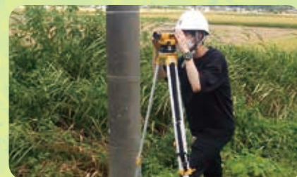
さかなお 酒直機場前道路の補修工事における測量の様 子。測地点ごとの勾配を測定しています。
