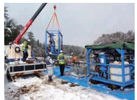
浄水装置設置作業(1月7日~8日)
