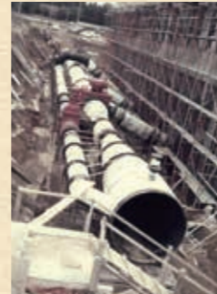
返田揚水機場パイプライン埋設時の様子
