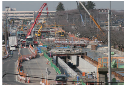
改築工事中の武蔵水路
