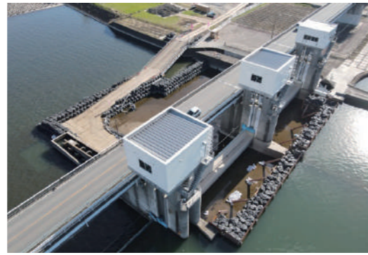
大規模地震対策事業で工事中の利根大堰
