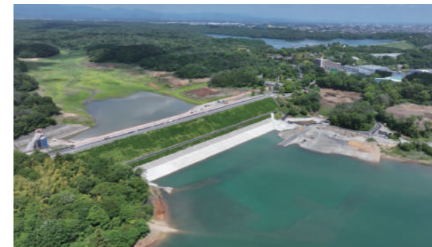
堤体強化が完了した村山上貯水池・村山下貯水池(東京都水道局提供)
