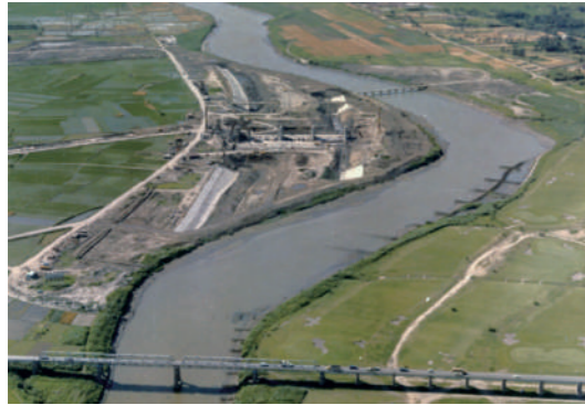
建設中の秋ヶ瀬取水堰(昭和39年5月)
