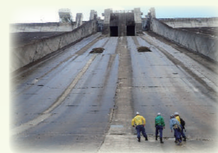
ダム等検査・点検(下久保ダム)
