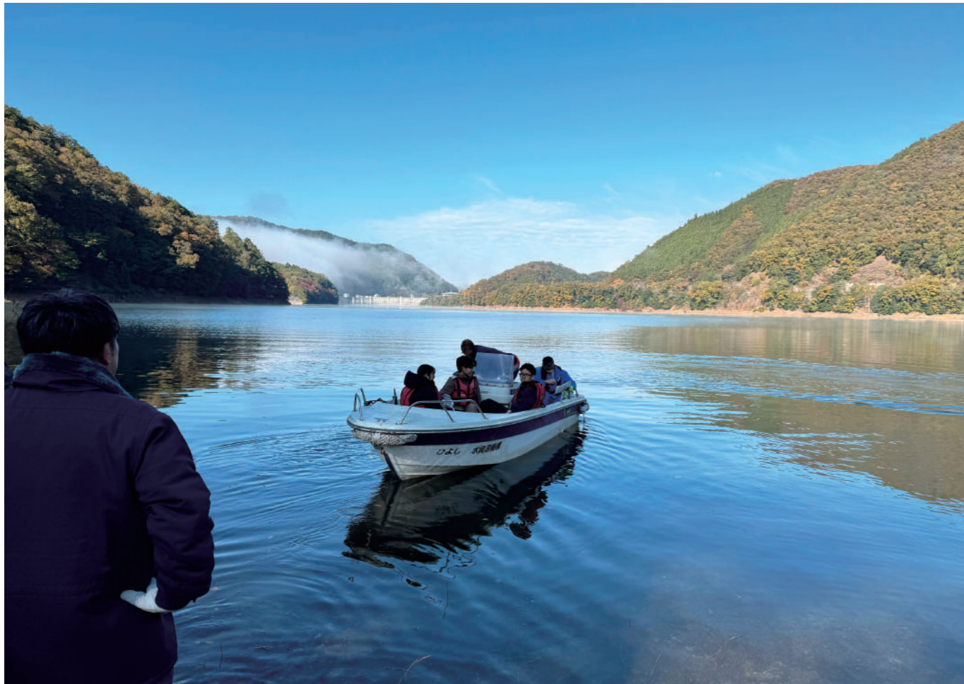
天若湖(日吉ダム)での設営作業状況
