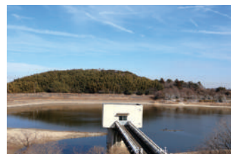
下流管理所操作室から望む前山池
