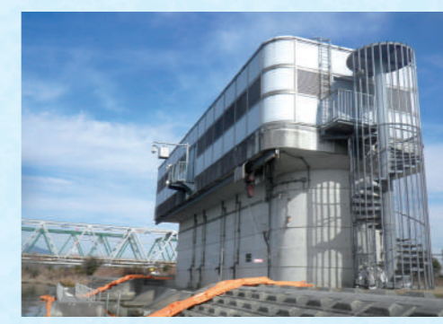
長良導水取水口
